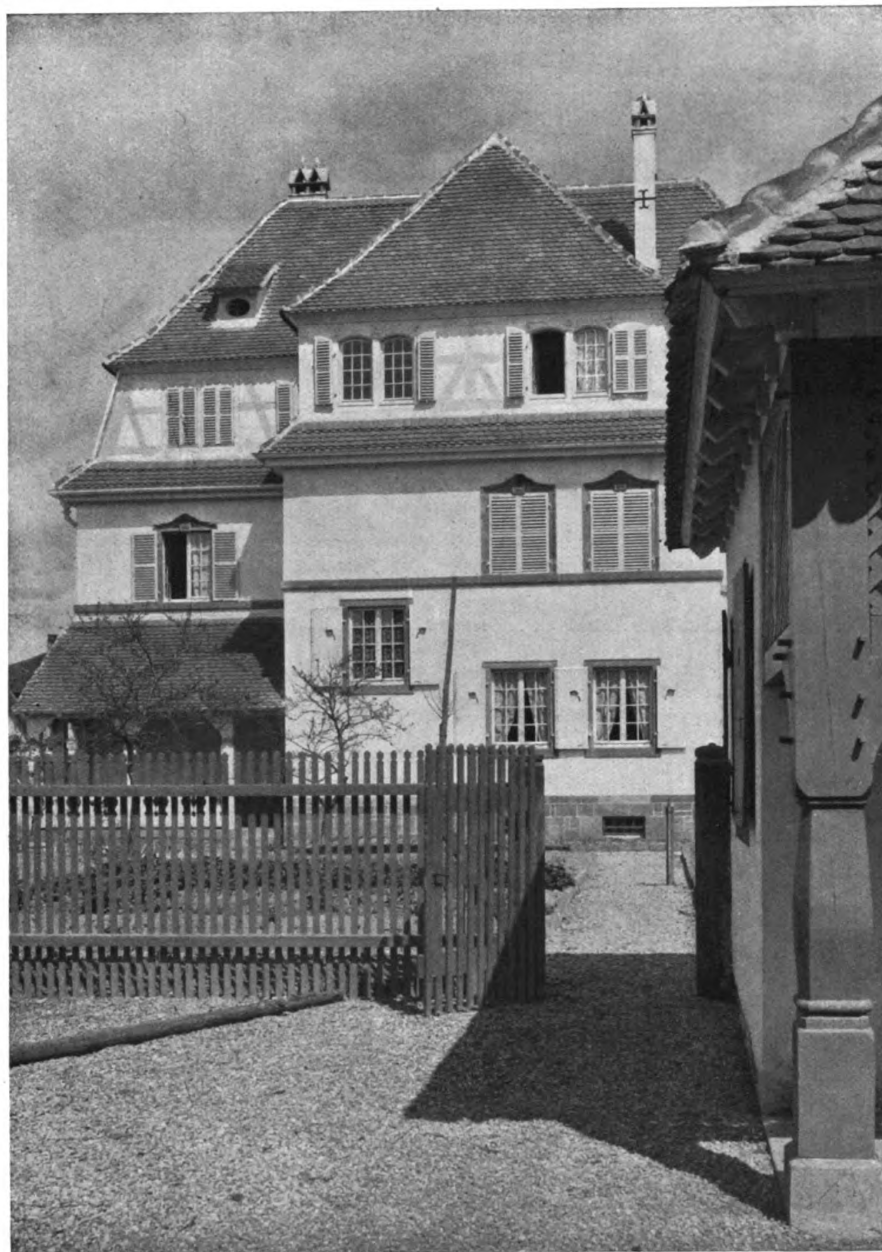
Fritz Beblo, Stadtbaurat, Straßburg i. E. Das Pfarrhaus in Neuhof. — Hofseite
