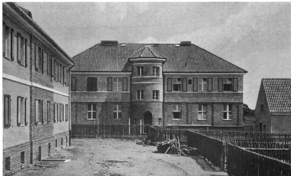
Bauinspektor Alfred Malpricht, Kattowitz O.-Schl. Von der Prinzengrube bei Mittel-Lazisk. — Beamtenwohnhaus II (vgl. S. 73) und Arbeiterwohnhaus für 8 Familien (vgl. S. 66 und 67) Vorder- und Rückansichten sowie Grundrisse des Beamtenwohnhauses. — Maßstab 1 : 400
