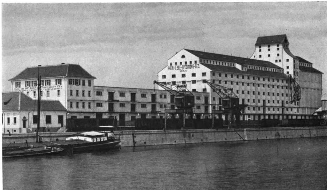
Fritz Beblo, Stadtbaurat, Straßburg i. E. Das große städtische Lagerhaus am Rheinhafen zu Straßburg i. E.
