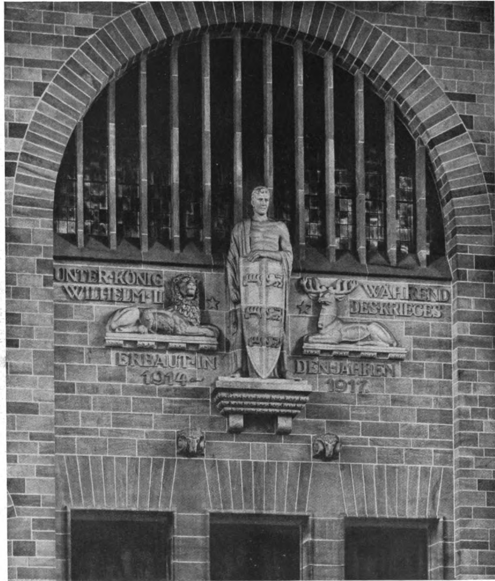
P. Bonatz und F. Scholer, Stuttgart Das Hauptbahnhofs-Gebäude in Stuttgart. — Detail aus der Schalterhalle Bildhauerei von Jakob Brüllmann, Stuttgart
