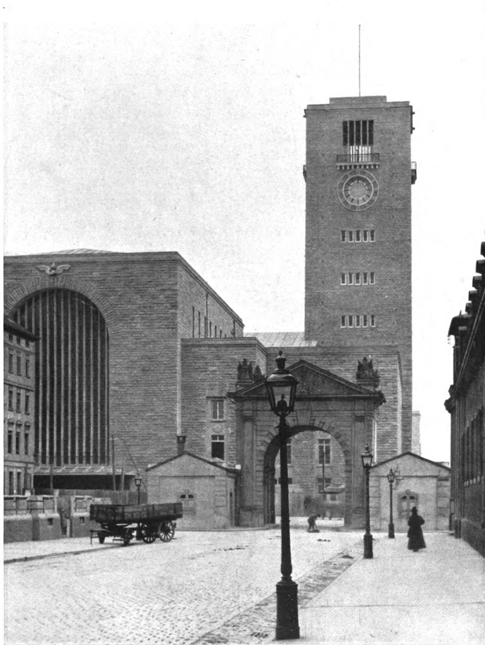
P. Bonatz und F. Scholer, Stuttgart Das Hauptbahnhofs-Gebäude in Stuttgart. — Hauptansicht von der unteren Königstraße
