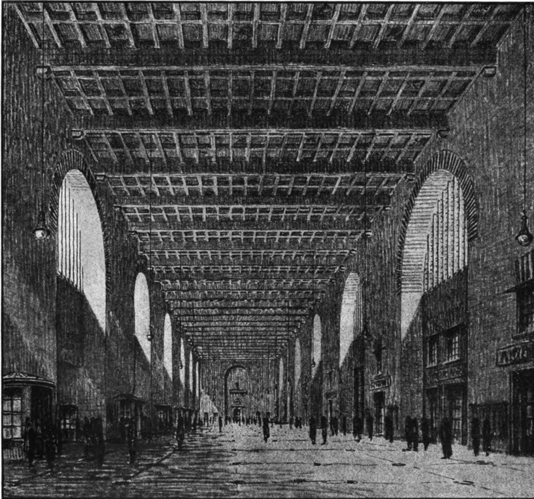
P. Bonatz und F. Scholer, Stuttgart Das Hauptbahnhofs-Gebäude in Stuttgart. — Die Kopfbahnsteighalle
