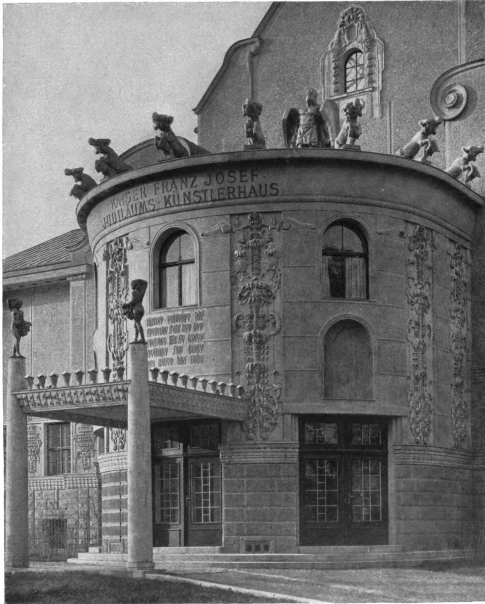
Heinrich Ried, Wien Das Künstlerhaus zu Brünn. — Der Mittelbau der Hauptfassade
