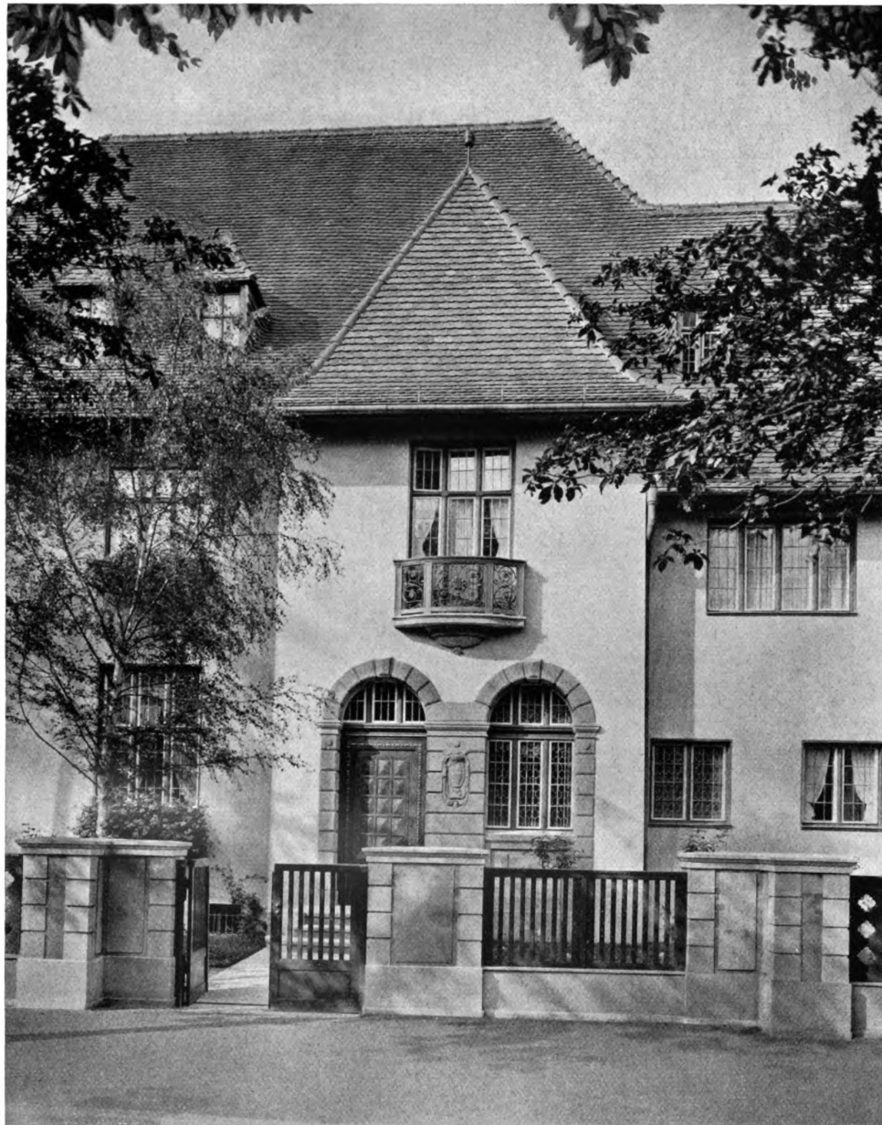
Max Landsberg, Berlin Das Wohnhaus Prof. Dr. Blaschko in Berlin-Grunewald Eingangs-Risalit an der Straßenseite
