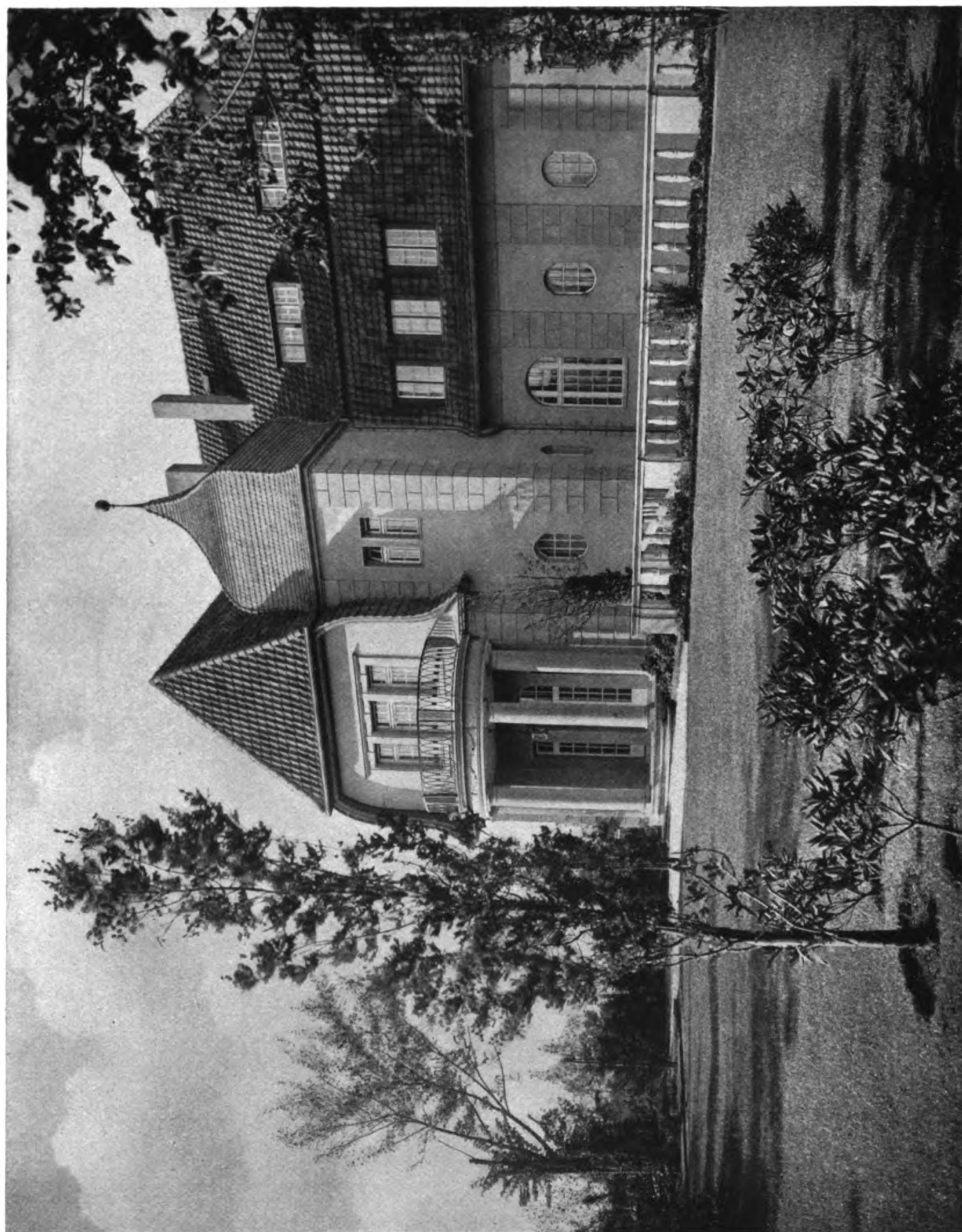
Max Landsberg, Berlin Das Wohnhaus Dr. Ludwig Fulda in Berlin-Dahlem Der Speisezimmer-Risalit an der Gartenseite
