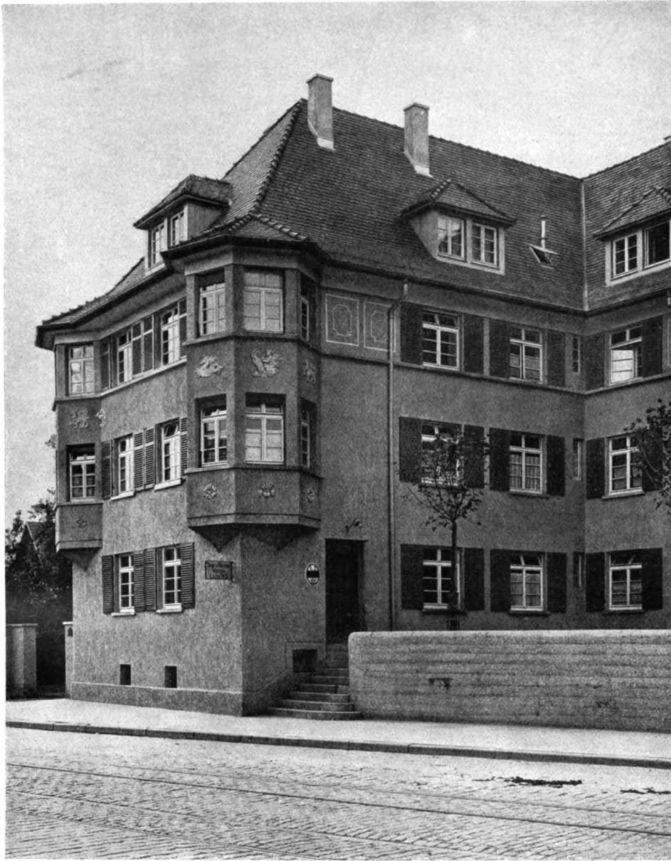
Albert Eitel, Stuttgart (Mitarbeiter Prof. Paul Beck) Die städtischen Kleinwohnungen in Wangen bei Stuttgart. — Vom Baublock „A“ an der Ulmerstraße
