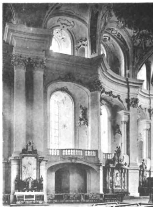
7. Neresheim: Aufbausystem an der Nordseite des Chores.
