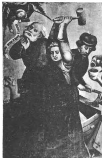
Abb. 7. Bau der Arche.
