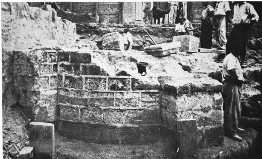
Abb. 4. Ansicht der südlichsten Kapelle von der Ostseite des Südquerhauses bei den Ausgrabungen von 1886. Nach einer Aufnahme bei Chevalier, Les fouilles de St. Martin de Tours, Tours 1888. Aus der zweiten Schicht. Chevalier wie R. de Lasteyrie haben hier Mauern aus den ersten Jahren des 11. Jahrhunderts sehen wollen. Auch abgesehen von den historischen Erwägungen, wäre dies nach dem Charakter der Technik höchst unwahrscheinlich, der nur auf das 12. Jahrhundert weisen kann. Denn in der nächsten Umgebung, in Poitiers (St. Hilaire) und Le Mans (Kathedrale) wird noch in der Mitte des 11. Jahrhunderts Bruchsteinmauerwerk sehr unvollkommener Art verwandt.
