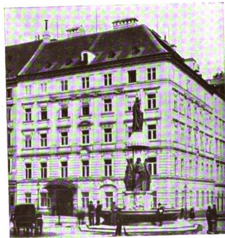
Abb 9. Freiong-Rennngasse, Demolierter Ostblock mit Austriabrunnen
