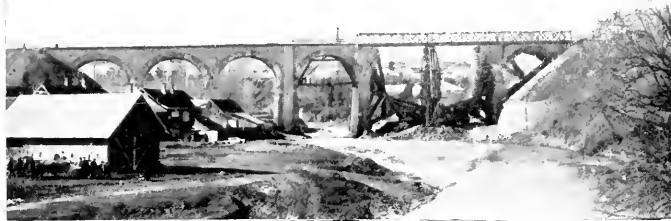
Gesprenzte und wiederhergestellte Eisenbahnbrücke bei Grybów.
