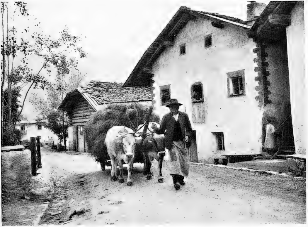
VIGO DI FASSA (4,565 FEET): DOLOMITEN STRASSE
