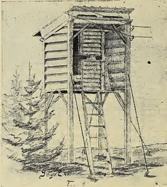
Fig. 25. Instrumenthuset i observatoriets have.
