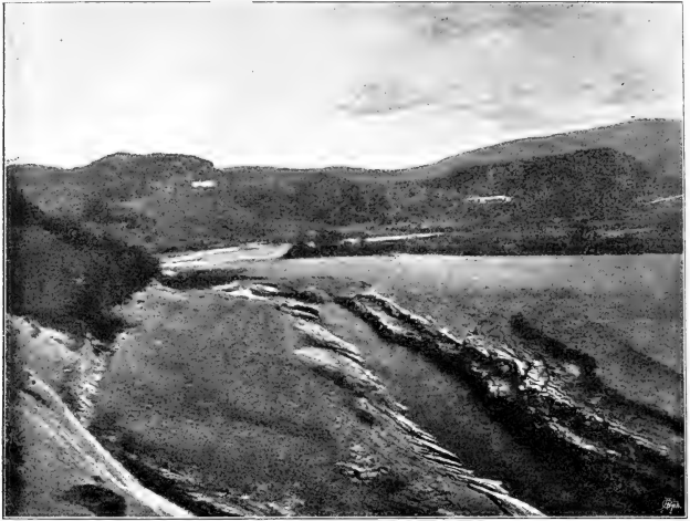
Fig. 8. Værdalselvens gravning ved Volden 1894.
