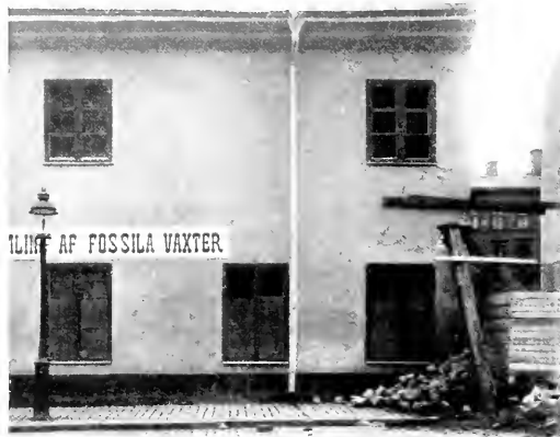
Parti af västra gafveln af Riksmuseets kvarstående byggnad med de paleobotaniska och etnografiska afdelningarna i kvarteret »Grönlandet södra». Efter fotografi af G. Holm 1910. Obs. sprickorna i väggen och uppsatta stötter.
