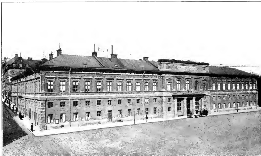
Södra fasaden (mot Vallingatan) af Vetenskapsakademiens hus.
