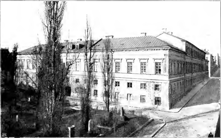
Riksmuseets fasad mot Hollandaregatan.
