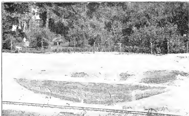
Fig. 3. Profil durch ein kleines ehemaliges Wasserbecken, verlandet durch vollständige Ausfüllung mit Sapropelgestein, darüber Torf, das Ganze bedeckt mit Sand. Aufgeschlossen beim Bau des Teltowkanals bei Steglitz bei Berlin.
