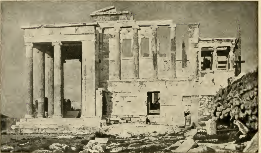
Abb. 2. Das Erechtheion von Westen
