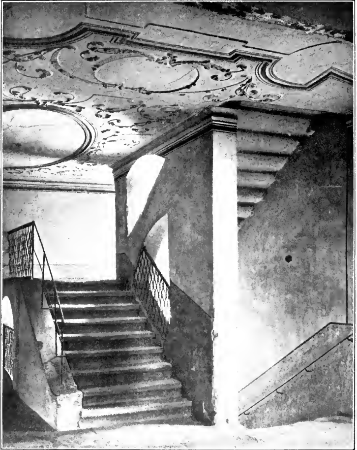
Treppenaufgang im nördlichen Baue der Pilzläuben in Görlitz.
