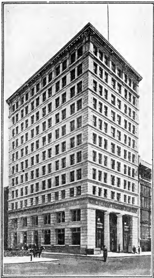
« Day and night Bank » de New-York. Vue extérieure.
