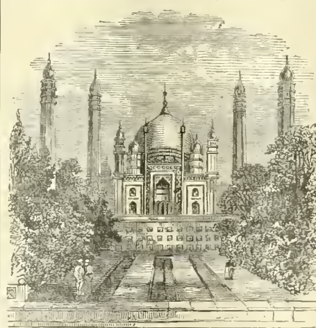
Mosquée d'Aurungzèbe à Aurungabad.
