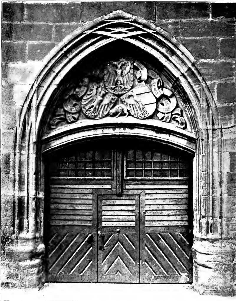
Abb. 55. Portal der Mauthalle (vor dem Umbau des Gebäudes). (S. 84.) Phot. von M. Stich vormals f. Schmidt.
