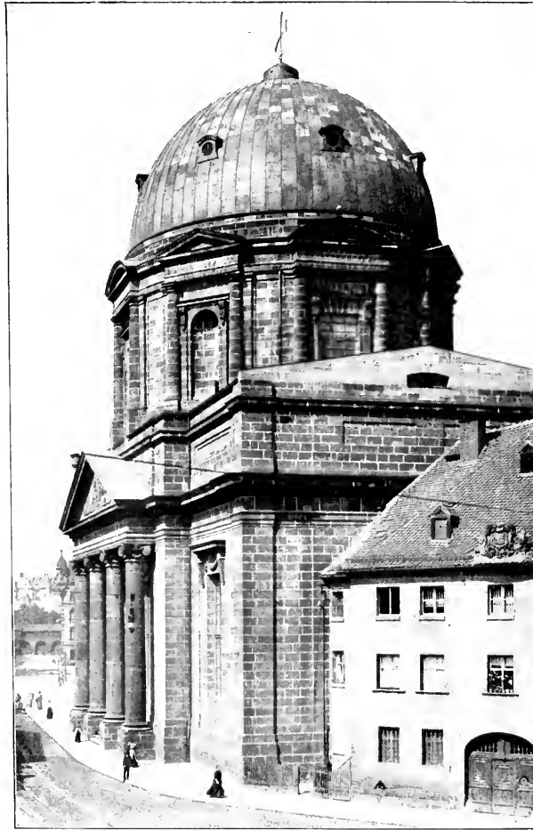
Abb. 185. Deutschhauskirche. (S. 249.) Phot. von M. Stich vormals J. Schmidt.
