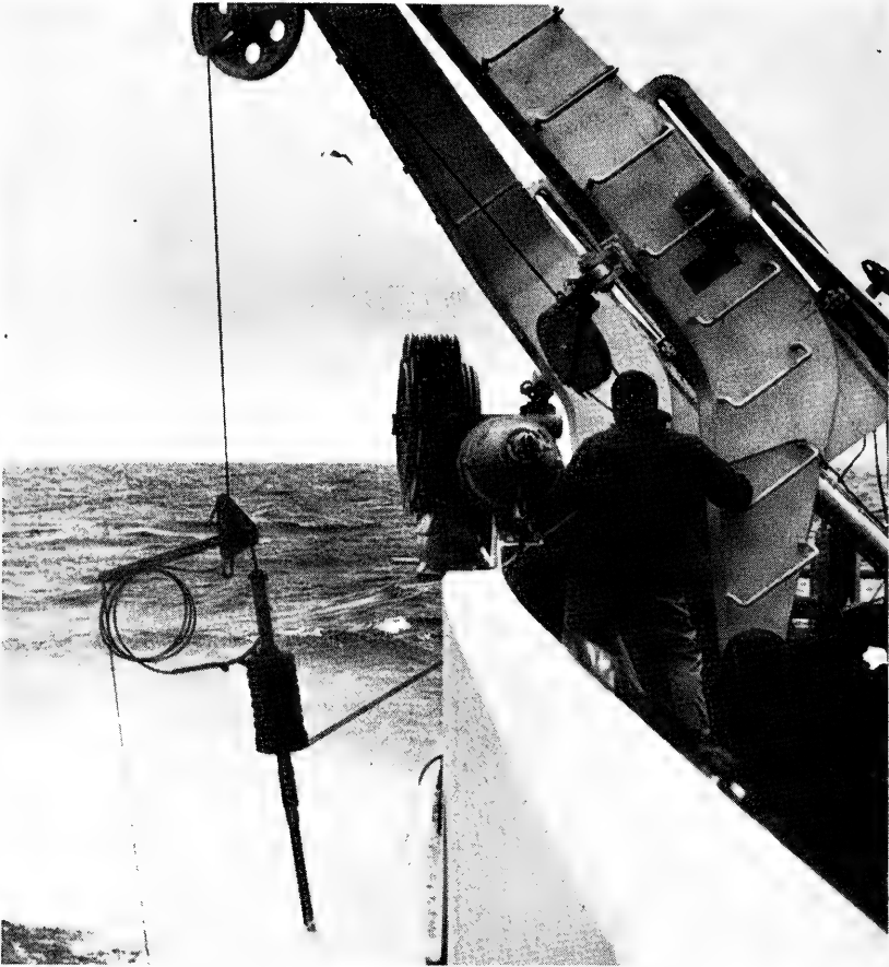
Bottom-coring operations from U. S. N. S. Bent.
