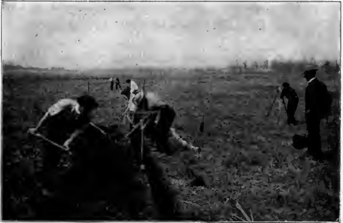
FIG. 48. LAYING TILE
