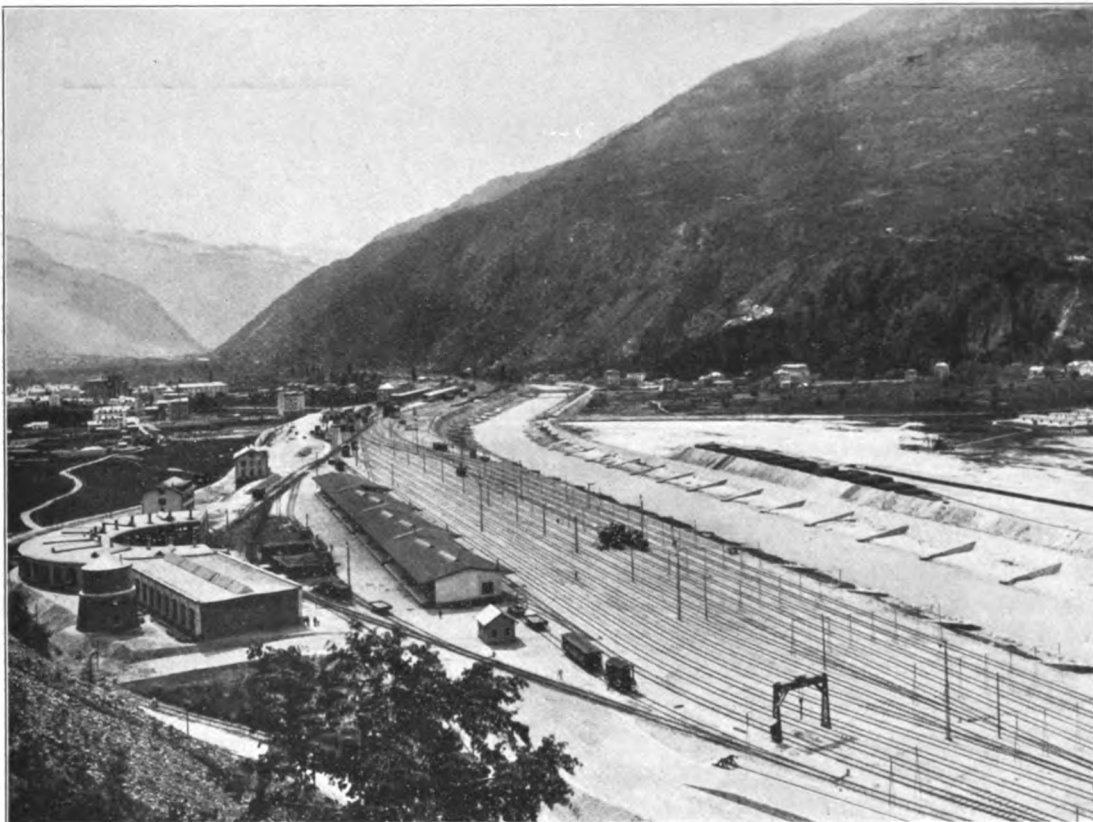
Abb. 2. Elektrische Oberleitung in Brig.
