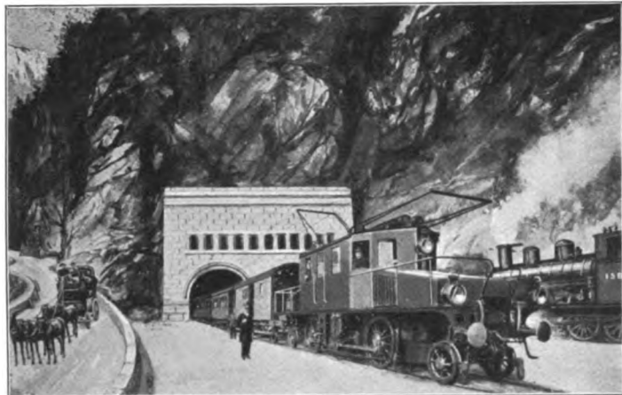
Abb. 4. Elektrische Oberleitung und Weiche in Brig.
