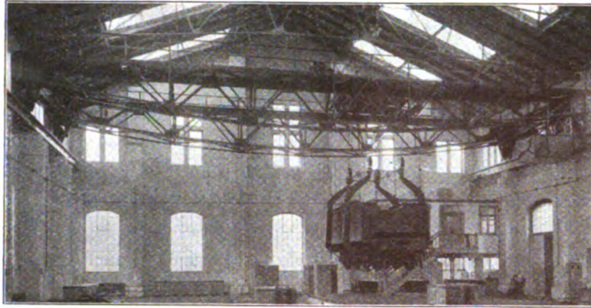
Abb. 2. Kran zum Heben von Tendern.
