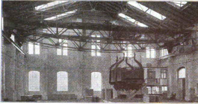
Abb. 2. Kran zum Heben von Tendern.
