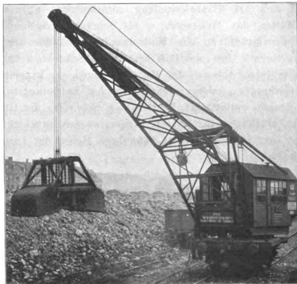
Abb. 1. Elektrisch betriebener, regelspuriger Greiferkran.
