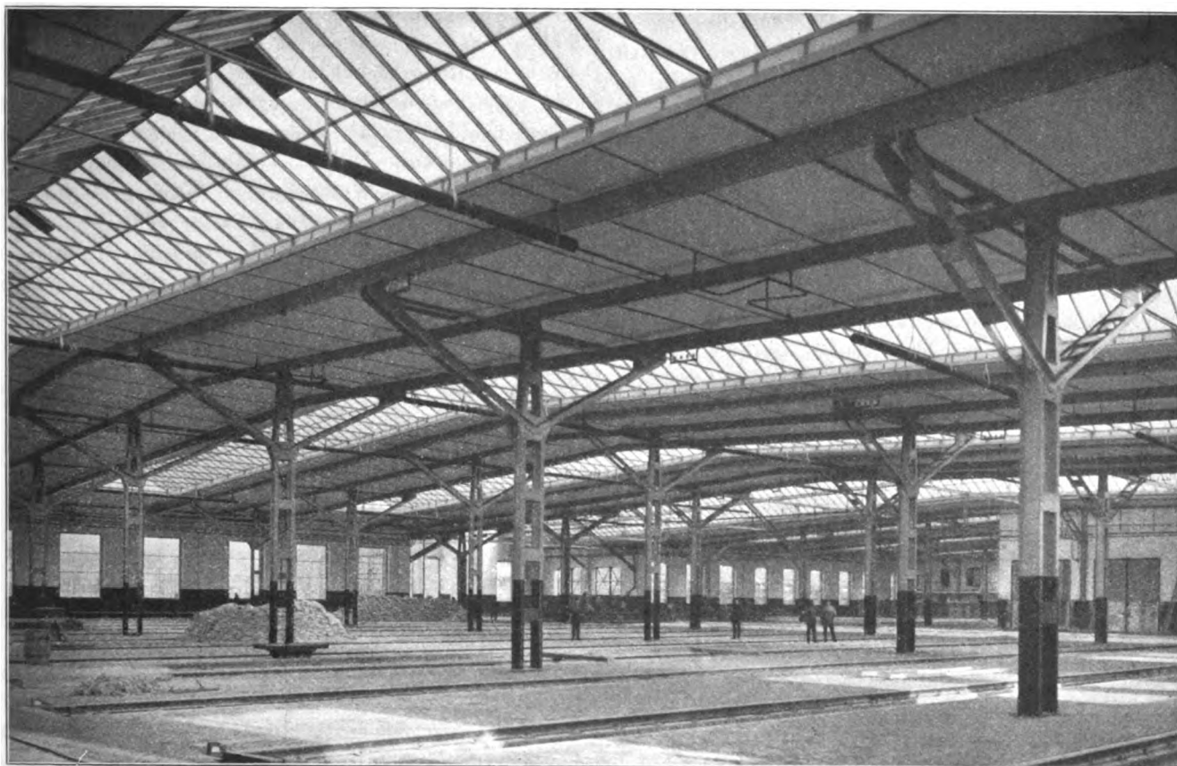
Abb. 2. Die Ausbesserungshallen der neuen Wagen-Werkstätte.
