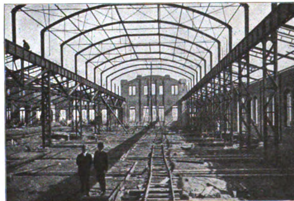
Abb. 1. Lokomotivhalle III. Hauptfeld.
