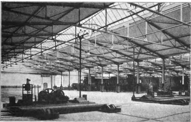
Abb. 41. Glühlichtbeleuchtung in der Wagenhalle.
