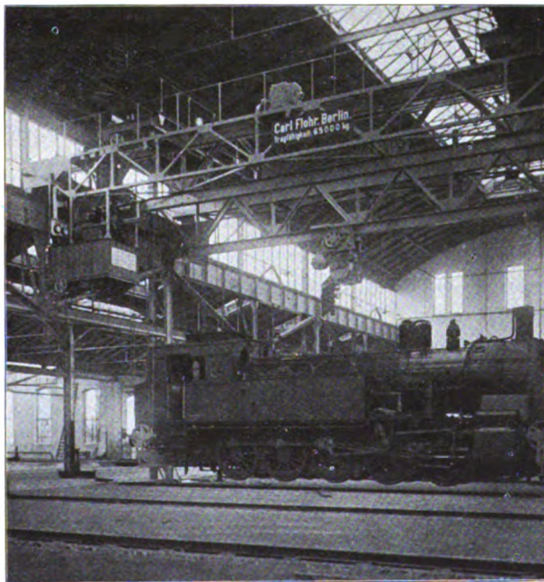
Abb. 4. Lokomotivhebekran.
