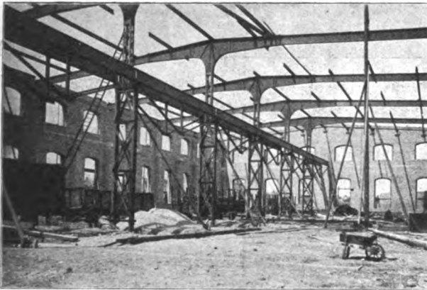
Abb. 7. Kesselschmiede im Bau.
