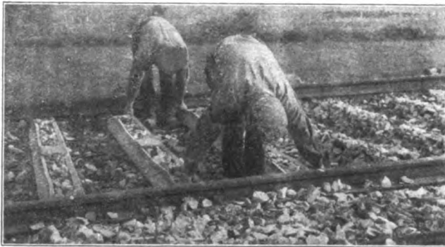
Abb. 5. Die eisernen Schwellen sind auf den Bettungskörpern verlegt.
