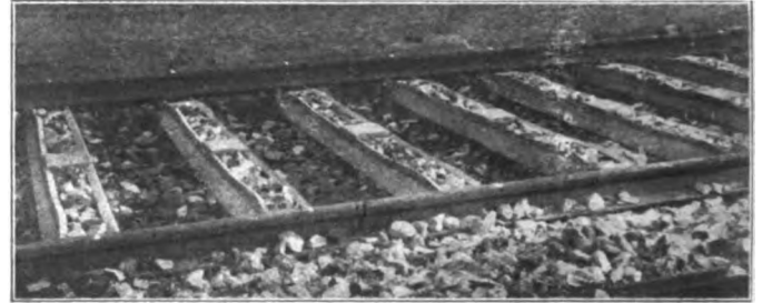
Abb. 2. Die Kastenlehren sind fertig verfüllt und festgestampft.
