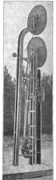
Abb. 2. Seitenansicht des Doppelscheiben-Vorsignales.
