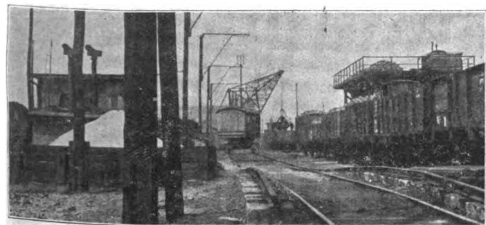
Abb. 9. Anlage zum Umsetzen des Kranes in Frintrop.
