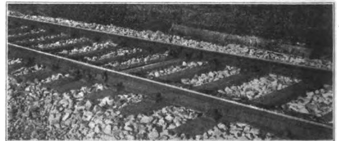
Abb. 6. Fertig gestopftes Gleis.
