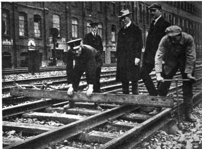
Abb. 4. Ausrichten der Lehrschiene.
