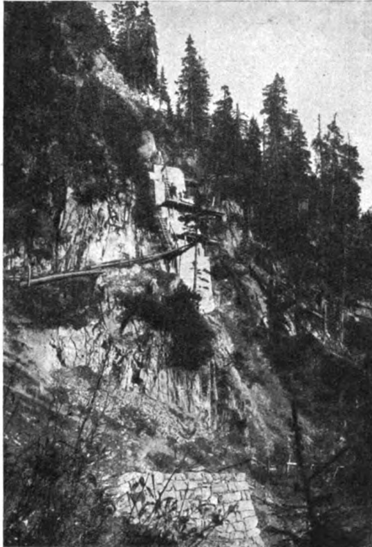
Abb. 3. Steinschlagverbauung im „Längentobel“ bei Langen am Arlberg.
