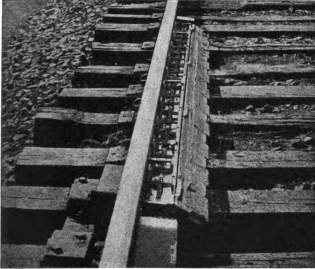
Schienen schmivorrichtung mit abgehobenem Deckel. Die teilweise im Öl befindlichen Lederscheiben sind sichtbar.
