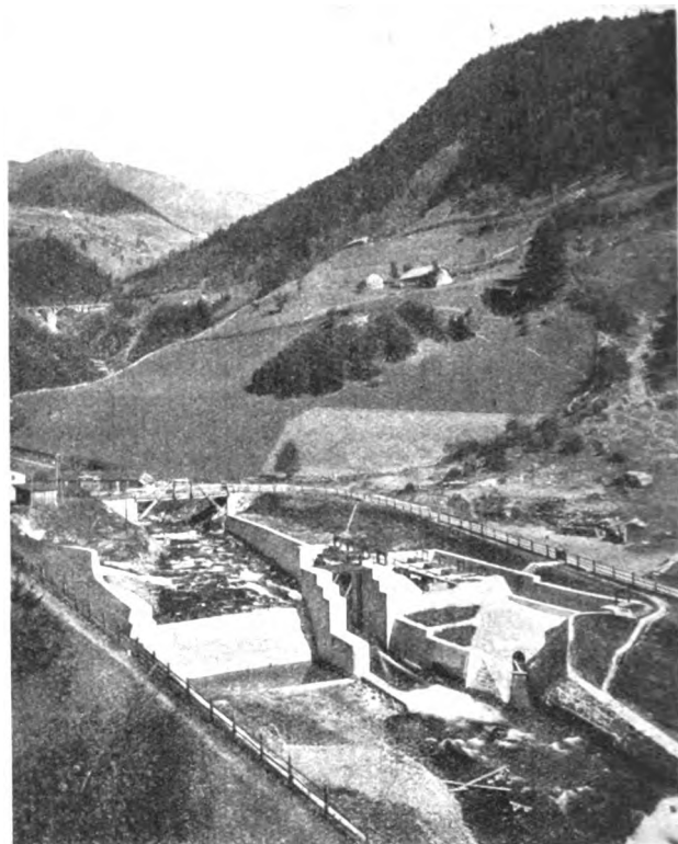
Abb. 19. Mallnitzwerk: Wehr (rechts Entsandungsanlage, Patente Büchi). Im Hintergrund, der Dössenviadukt der Tauernbahn.
