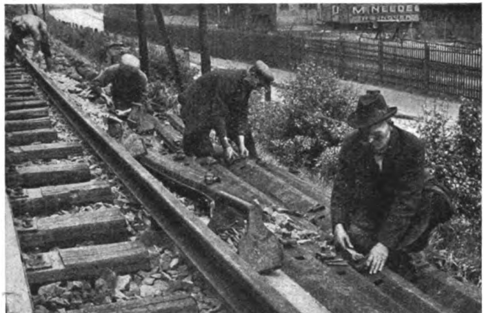
Abb. 9. Einsetzen der äußeren Befestigungsteile.
