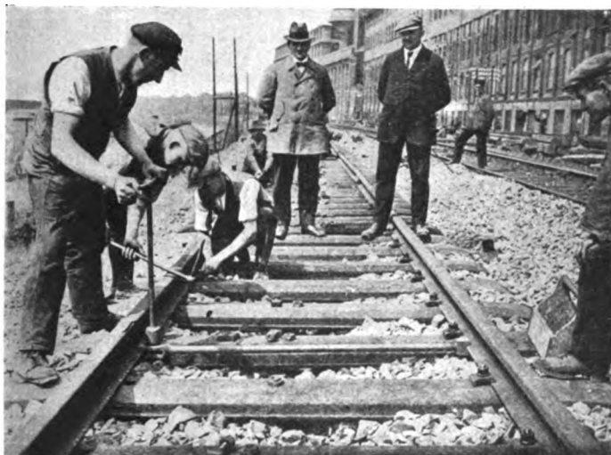
Abb. 14. Spreizen der Schienen in ihre richtige Lage und Anbringen der inneren Befestigung.
