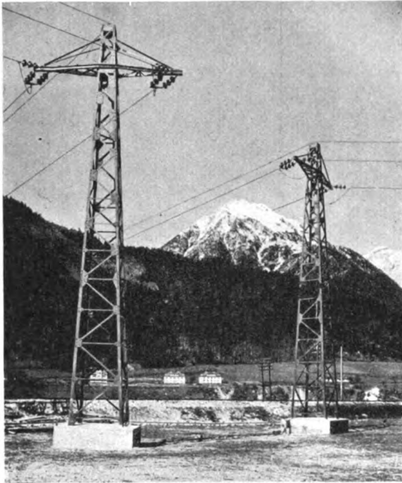
Abb. 1. Übertragungsleitung Wörgl—Hall; Einführung der Leitung in das Achenseewerk. (Knüppelisolatoren.) (Elin A.-G.)
