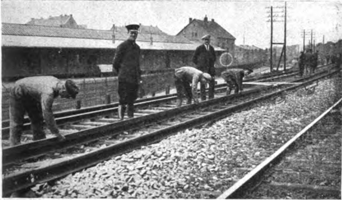
Abb. 6. Anzeichnen der Schwellenteilung auf die alte Außenschiene in Bögen.
