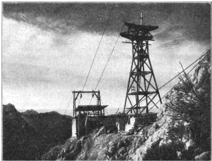
Abb. 3. Stütze III im Bau. Hilfsbahnbock 9.
