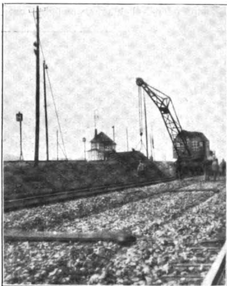
Abb. 5. Rille gezogen. Stofs-Breitschwellen als Richtpunkte verlegt.
