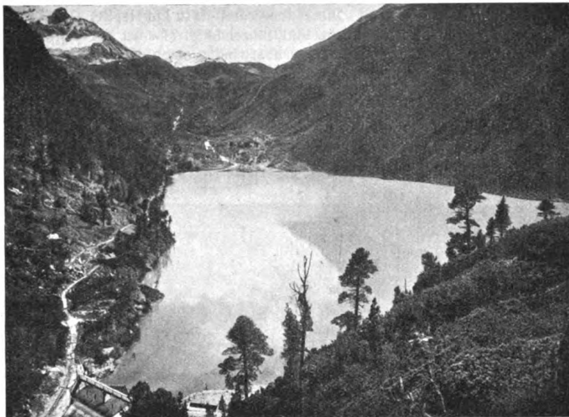
Abb. 16. Stubachwerk Ansicht des Grünsees mit Wehr.
