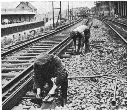
Abb. 3. Verlegen der Richtböcke.
