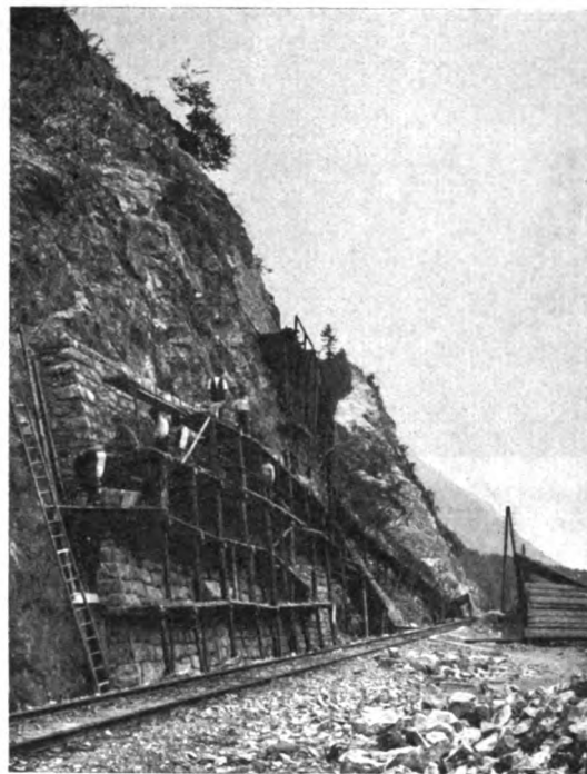
Abb. 2. Verkleidungsmauer bei km 118,1/2 der Strecke Innsbruck—Bludenz.
