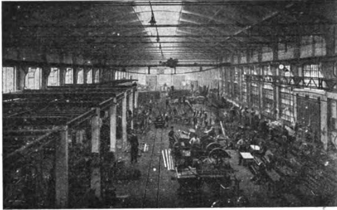
Abb. 2. Innenansicht der Werkstättenhalle.
