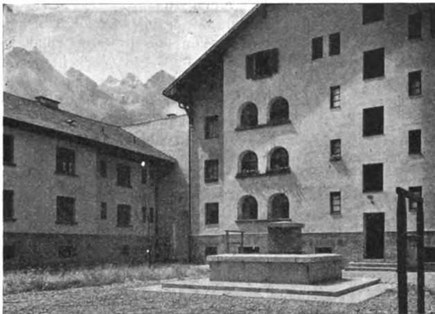
Abb. 2. Wohnanlage der Österreichischen Bundesbahnen in Bludenz, Hofgebäude.
