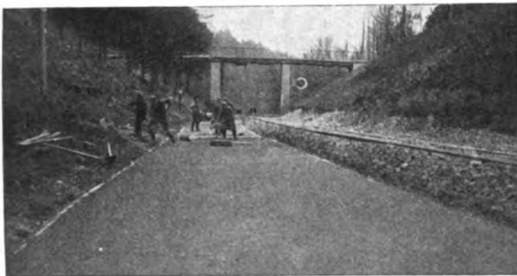
Abb. 7. Im Vordergrund Aufbringen der bituminösen Feinschicht (Körnung 0 bis 5 mm).
