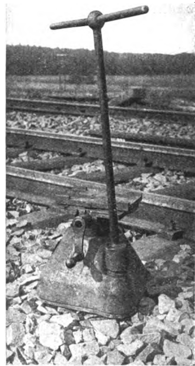
Abb. 2. Richtbock nach oben und seitlich verstellbar.
