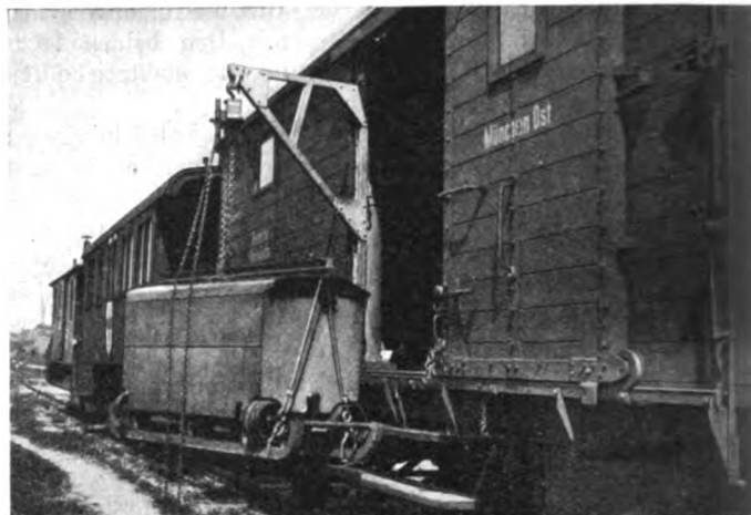
Abb. 2. Verladeeinrichtung für die Maschinenanlage.
