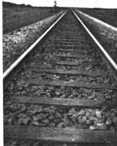
Abb. 4. Mit Triolith getränkte Kiefernswellen in der Versuchsstrecke der Deutschen Reichsbahn bei Küstrin nach Ablauf der zwölfjährigen Gewährzeit. Auswechslung rund 1%.
