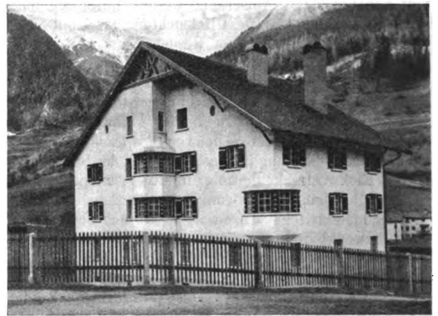
Abb. 5. Bediensteten-Wohngebäude in Flirsch a. Arlberg.
