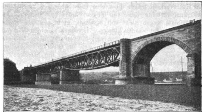
Abb. 15. Ansicht der fertigen Brücke nach dem Umbau.
