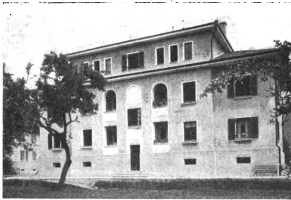
Abb. 1. Bediensteten-Wohngebäude der Österreichischen Bundesbahnen in Bregenz.
