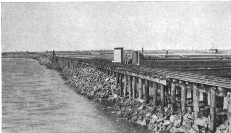
Abb. 4. Mit Steinen eingeschüttete Spundwand.
