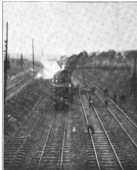
Vorher zusammengesetzte Joche. Krangleis. Umbangleis.
