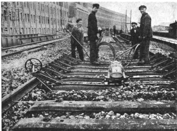
Abb. 11. Stampfen der Bettungsrücken und Verlegen der Schwellen.
