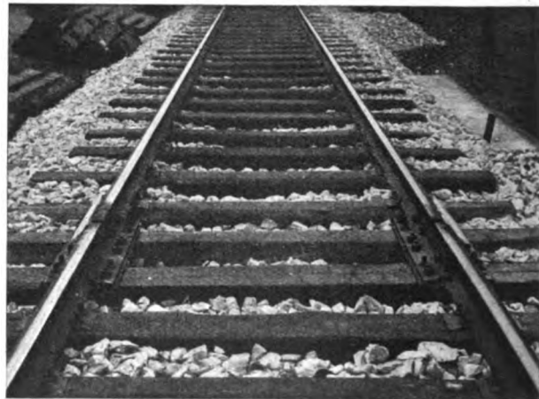
Abb. 5. Ausziehstofs Bauart Hesse (eine Schiene ist mit der Lasche fest verbunden).
