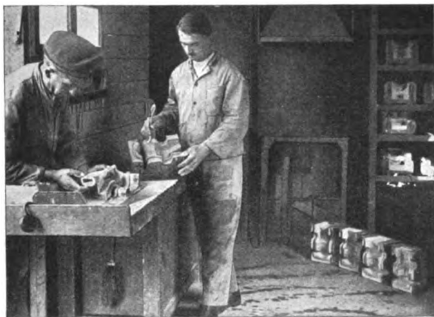
Abb. 2. Die Former während der Arbeit im Innern des Wagens.
