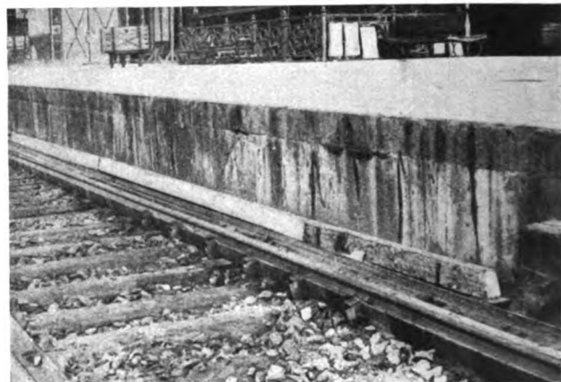
Abb. 5. Holzlehrschiene an Bahnsteigen und sonstigen Hindernissen.
