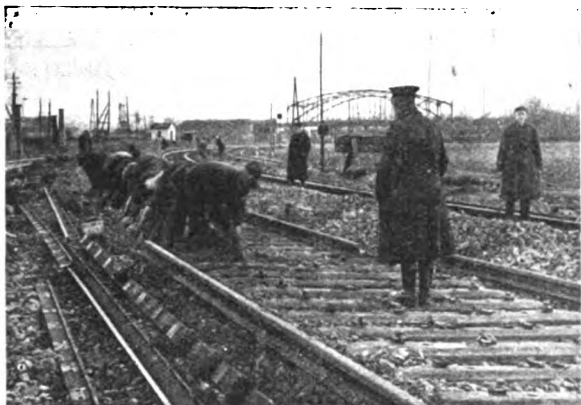
Abb. 12. Aufsetzen der Schienen.
