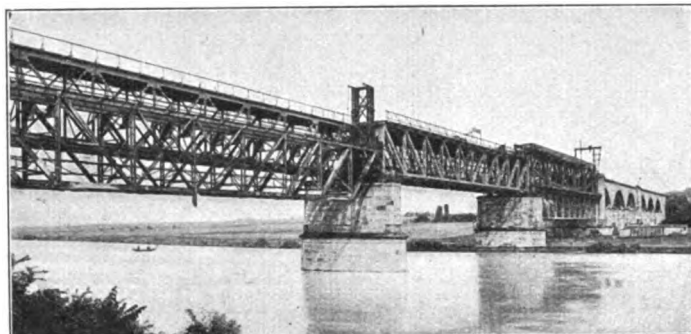
Abb. 4d. Absenken des linksuferigen alten Überbaues. Der alte Überbau über der Mittelloffnung ruht noch in seiner alten Lage. Der Zusammenbau des neuen rechtsuferigen Überbaues geht der Vollendung entgegen.
