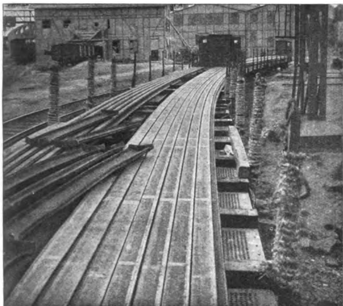
Eine Ladung von 30 m langen Schienen in einer Gleiskrümmung von 225 m Halbmesser.
