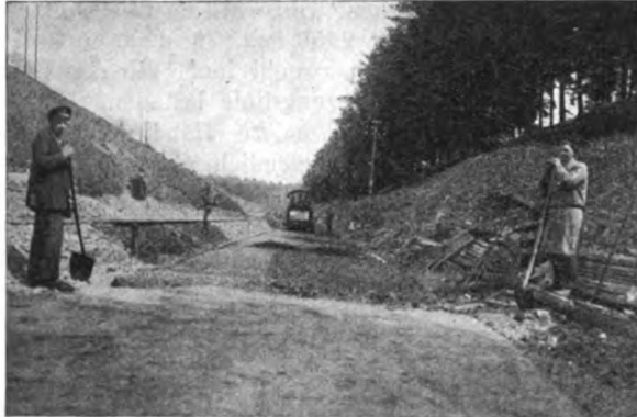
Abb. 6. Im Vordergrund das abgewalzte Planum mit aufgewalzter 2 bis 5 cm starker Sand- oder Schlackenschichte. Im Hintergrunde Aufbringen und Einwalzen der 4 bis 5 cm starken bituminösen Masse.
