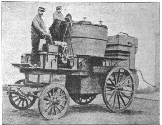
Fig. 7. Wasserstoffgenerator nach dem Kalziumhydridverfahren.
