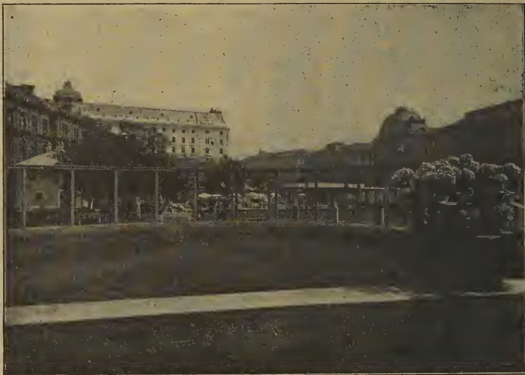
Fig. 40. Betonkolonnade a. d. Frühjahrs-Ausstellung d. k. k. öst. Museums.
