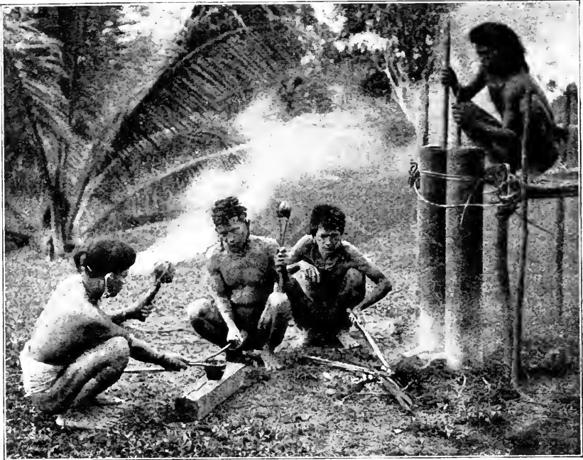
Abb. 538. Kalabit bei der Schmiedearbeit mit stehendem Kolbengebläse und Steinhämmern, Serawak, Borneo
