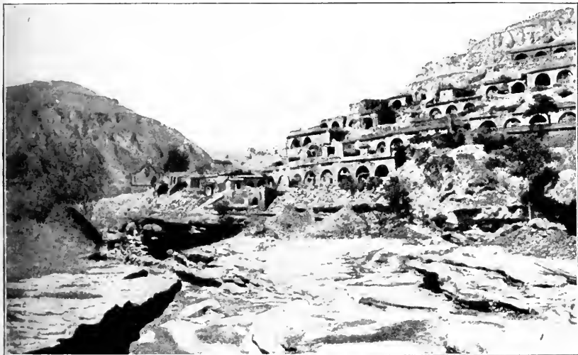
Abb. 375. Löböhlenort Dupi. Löböhlen mit gemauerten Gewölbefronten. (Die Mehrzahl der Häuser steht seit den Hungerjahren leer) (Nach A. Tafel, Meine Tibetreise)
