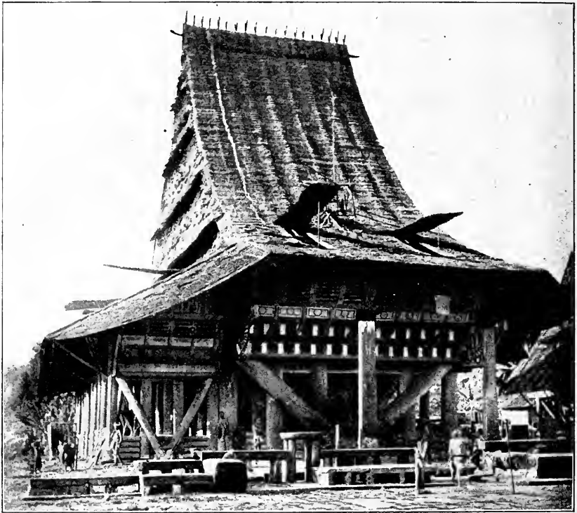
Abb. 502. Häuptlingshaus in Suidias, im Vordergrund Steindenkmäler (Nach E. E. W. Gs. Schröder, Nias)
