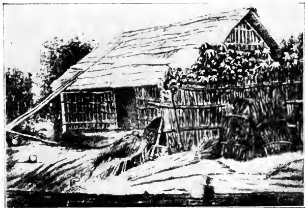
Abb. 328. Einfaches Bauernhaus mit Rohrwänden und Strohdach (Nach G. Grierson)
