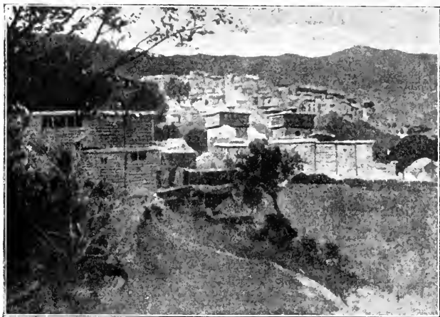
Abb. 310. Kafiridorf, Hindukusch; im Vordergrund einige Wehrtürme, im Oberstock aus Holzblockwerk erbaut (Nach Robertson)
