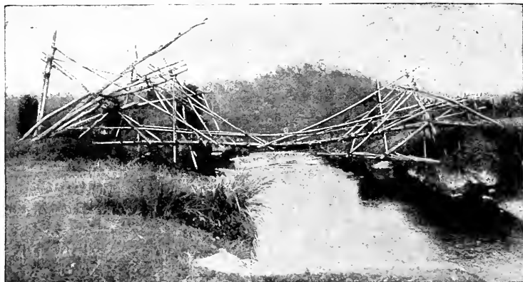
Abb. 510. Hängewerkbrücke der Toradscha aus Bambus, Zentralcelebes (Nach A. Grubauer, Unter Kopffägern in Zentralcelebes)
