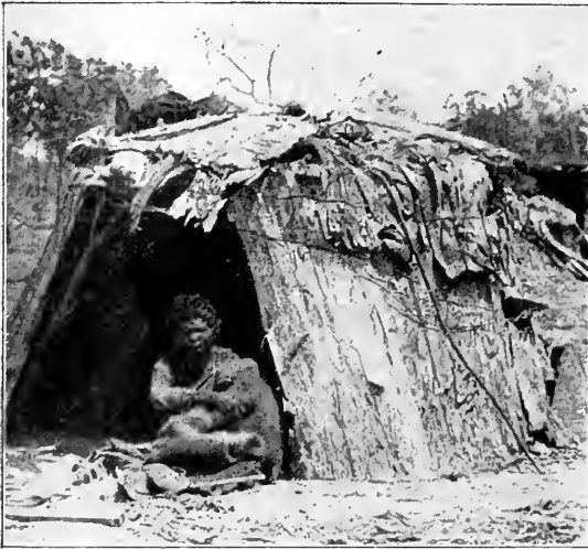
Abb. 7. Mit Rinde gedeckte Hütte der Australier (Phot. Klaatsch)
