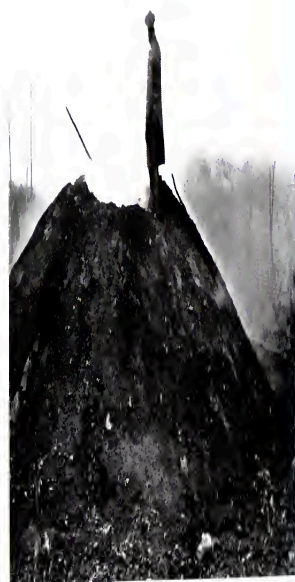
FIG. 2.—BURNING A KILN.
