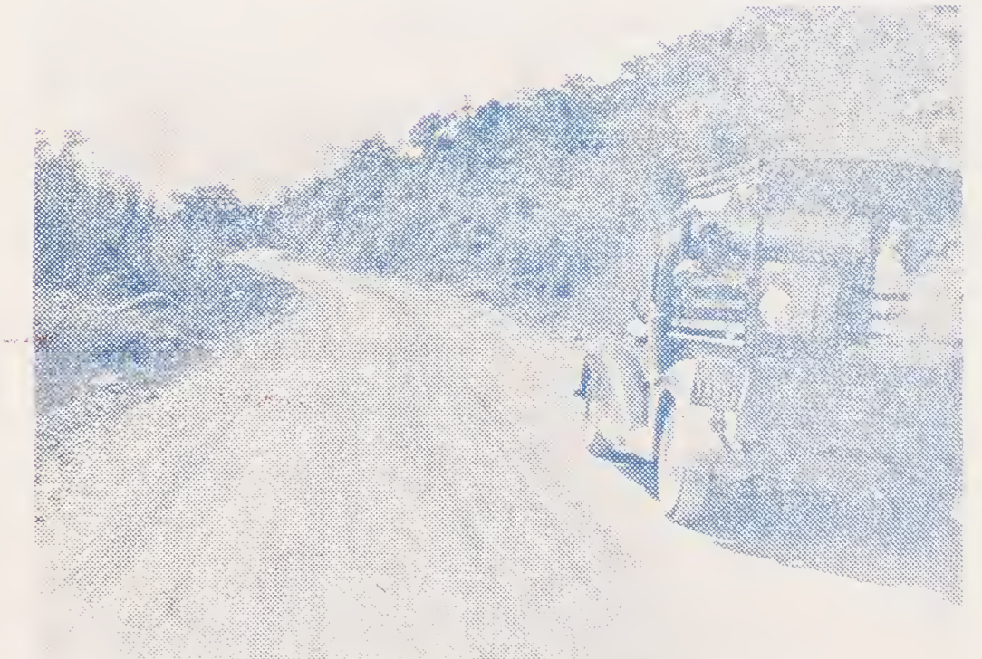
Vista de nuestra carretera terminada. Nótese el ancho, lo cual brinda completa seguridad al viajero.
