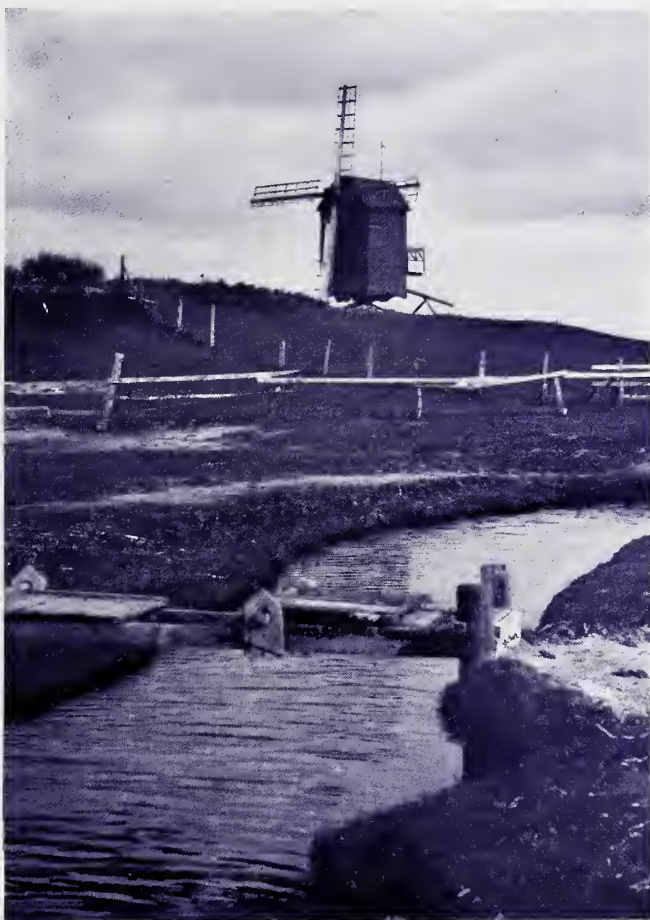
G. WEIGELT, WYK A. FÖHR Fallbrücke der Hallig
