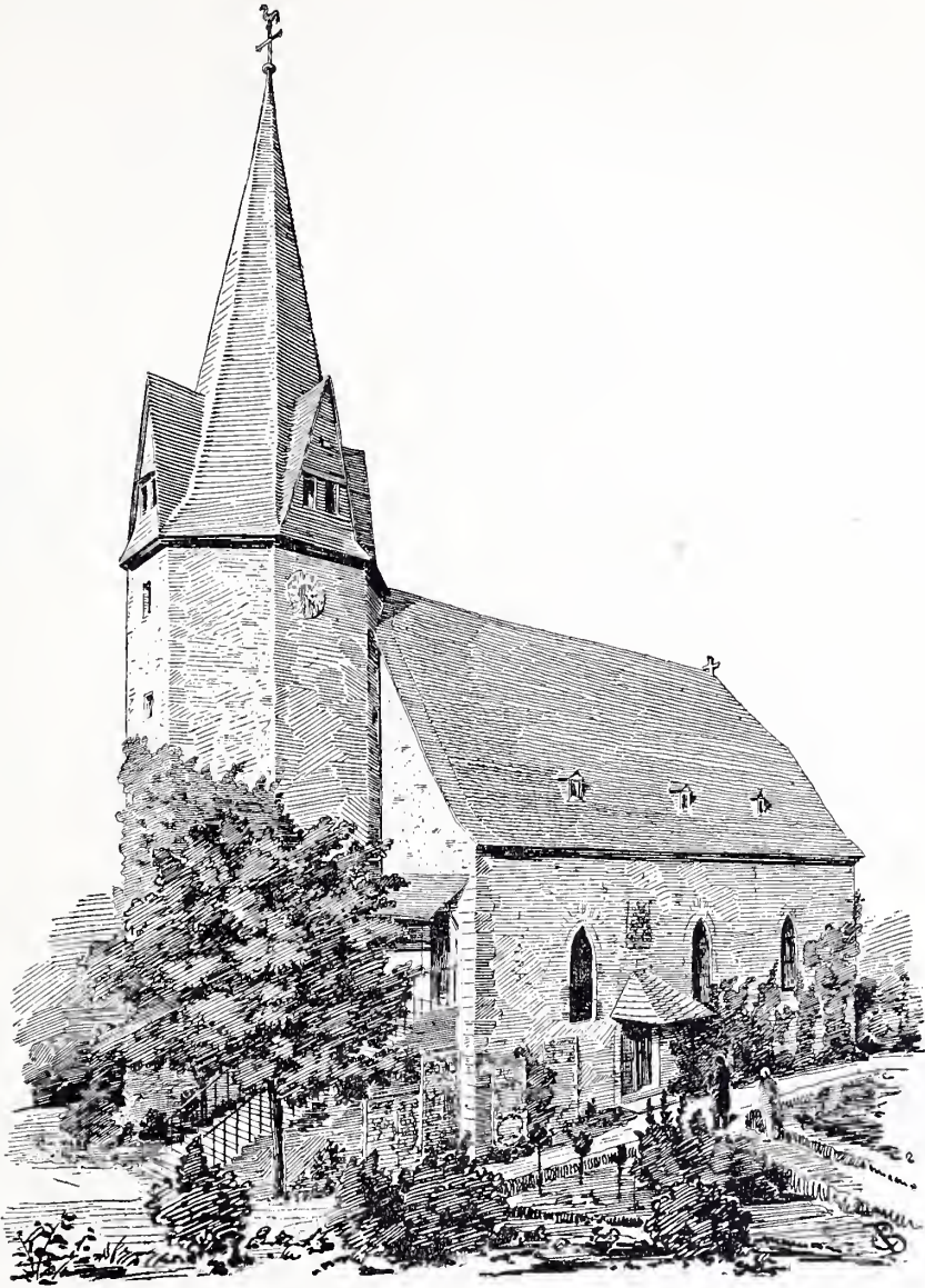
Fig. 100. Langenhain. Ansicht der Kirche.
