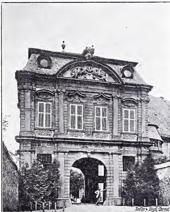
Fig. 95. Ilbenstadt. Thorbau des Schlosses. Ansicht von Süden.
