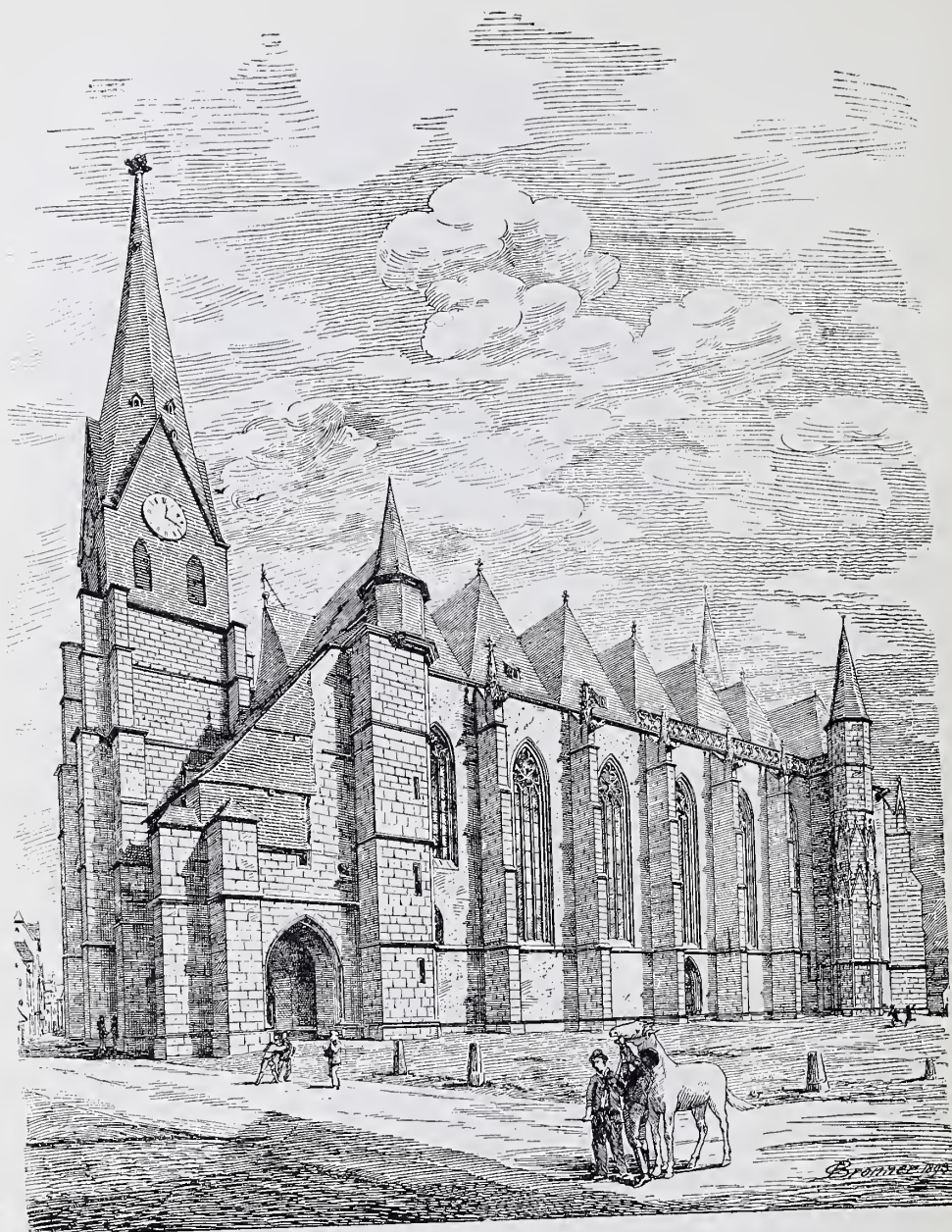
Fig. 48. Südseite der Stadtkirche zu Friedberg.
