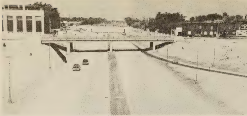
The Edsel Ford Expressway, Detroit, Mich.
