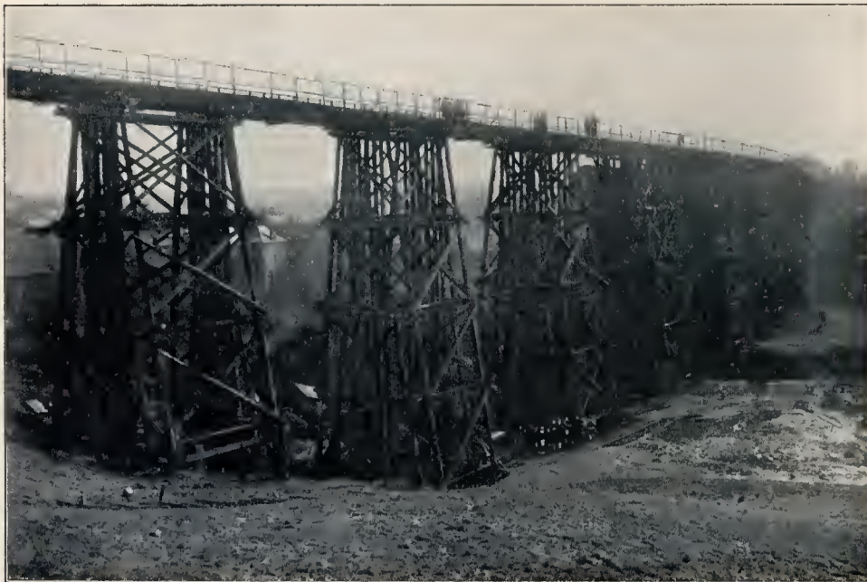
Ein Meisterwerk deutscher Pioniere: Die größte von den deutschen Truppen errichtete Eisenbahnbrücke. Sie wurde in Nordfrankreich an Stelle einer von den Franzosen gesprengten erbaut. Phot. Rich. Gutschmann.
