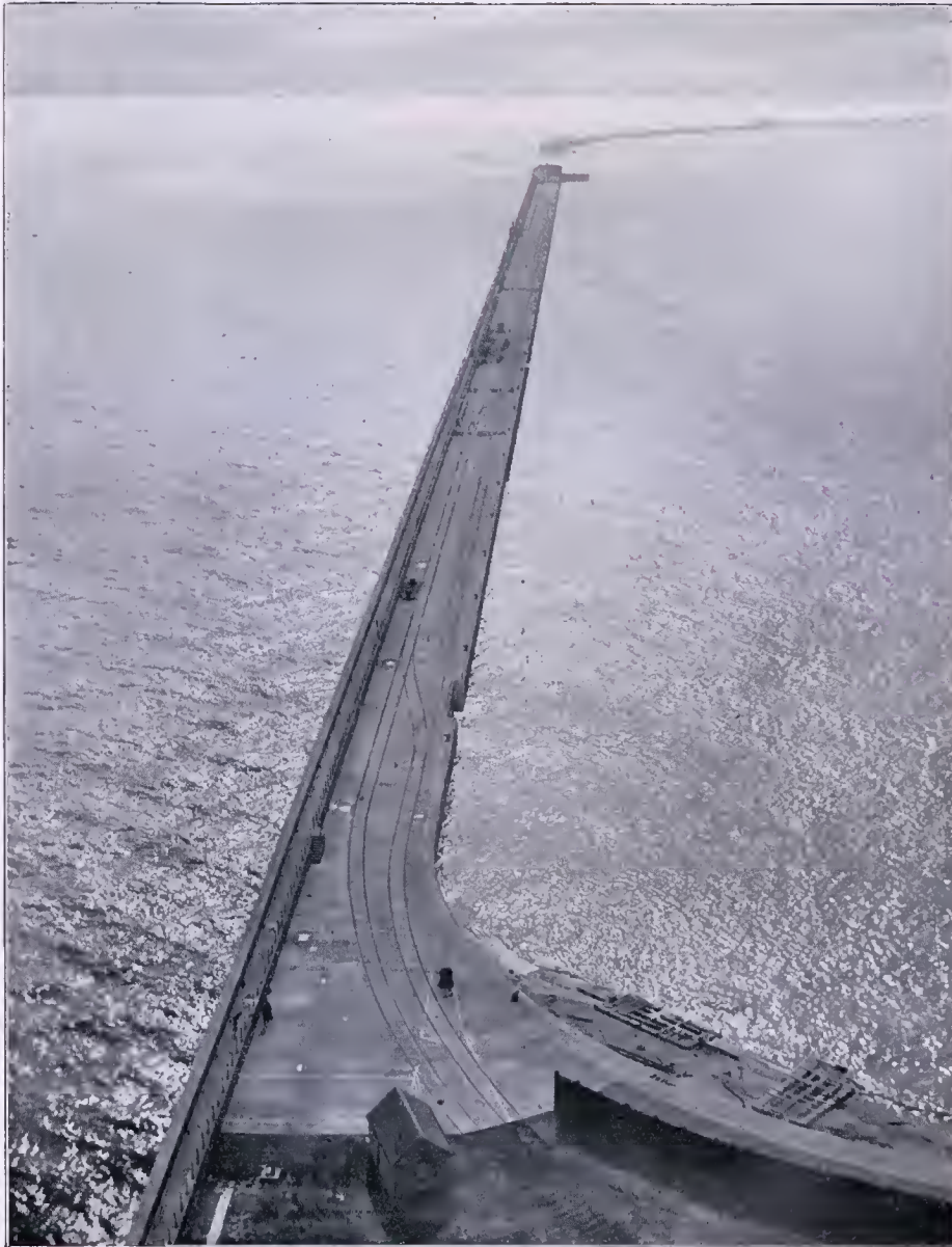
Der Kriegshafen von Dover, einer der Hauptstützpunkte der englischen Flotte. Die gewaltigen Neuanlagen des englischen Seehafens wurden vor vier Jahren eröffnet. Der Hafen zerfällt in einen Handels- und in einen Kriegs- marinehafen; letzterer faßt 15 große Kriegsschiffe und 14 Zerstörer und ist so tief, daß auch zur Ebbezeit die größten Schiffe einfahren können. Die Hafendämme haben eine Gesamtlänge von mehr als 3 km und umschließen eine Wasser- fläche von fast 300 ha. Die mächtigen Molen sind mit doppelten Eisenbahngleisen versehen, neben denen sich breite Gehwege hinziehen; sie sind sowohl zur Einschiffung von Mannschaften für die Kriegsmarine als für die Entladung von Handelsschiffen eingerichtet. Die Anlagen, die eine Bauzeit von 12 Jahren erforderten, kosteten rund 90 Millionen Mark.
