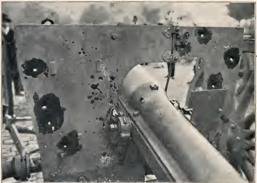
Die Wirkung des deutschen Infanteriegeschosses auf die französischen Haubitzenbeschütze, deren 1 cm starke Stahlplatte durchschlagen wird. Auch der 15 mm starke Messingmantel des Geschützrohrs wurde bis auf das Stahlrohr zerrissen. Das bei Dünne eroberte Geschütz ist in Saarbrücken aufgestellt. Phot. Aug. Klapp.
