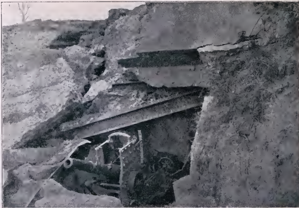
Ein von den Bayern ersticktes Nordfort von Przemysl. Die russischen Befestigungen, die eine Gesamtausdehnung von 50 km haben, bestanden aus kleineren und größeren Forts, die untereinander durch Schützengräben und sonstige Erdwerke verbunden waren. Die Forts waren mächtige, von tiefen Gräben umgebene Erdwerke mit zahlreichen betonierten Unterschlüpfen und gemauerten Kasernen. Breite, meist in zweifacher Reihe angelegte Drahthindernisse sperrten nach allen Seiten den Zugang zu den Befestigungsanlagen. Im ersten Angriff der verstärkten bayerischen Division fielen drei Forts der Nordfront samt den dazwischen gelegenen Befestigungsanlagen. Am 31. Mai gelang die Erstürmung der Forts IXa, Xa und XI samt Zwischenlinien. Bis zum Abend des 2. Juni hatte sich die durch Wegnahme der Forts XI und XII und Kapitulation der Werke Xb und IXa durchbrochene Linie zu einer Breite von 8 km erweitert, d. h. die ganze Nordfront, etwa der sechste Teil der gesamten Befestigungen, war im Besitz des Angreifers. Nach einer Belagerung von vier Tagen war Przemysl in unserem Besitz.
