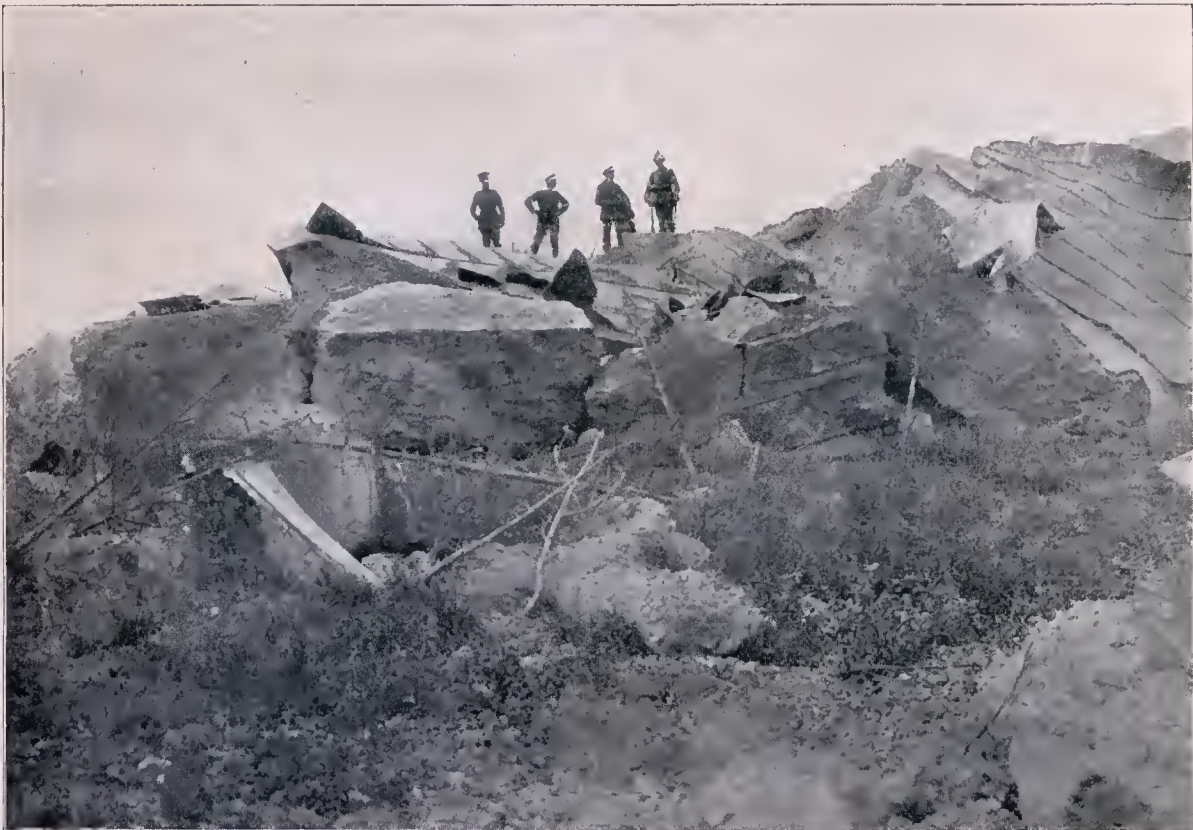
Fort XI von Przemysl nach der Beschießung durch schwere Artillerie. Die Aufnahme legt Zeugnis ab von der erschütternden Wirkung der schwersten Geschütze. Betonklöbe von 3 m Stärke sind geborsten und abgeplittert und gleichen zerstörten Sandburgen. Die Trichter der 42-cm-Geschosse weisen eine Tiefe bis zu 8 m und eine Breite bis zu 15 m auf. Die moralische Wirkung dieser Geschosse war eine derartige, daß die Russen an mehreren Stellen selbst die Drahtseile durchschnitten, um aus der unerträglichen Lage sich zu befreien und dem stürmenden Feind sich zu ergeben.
