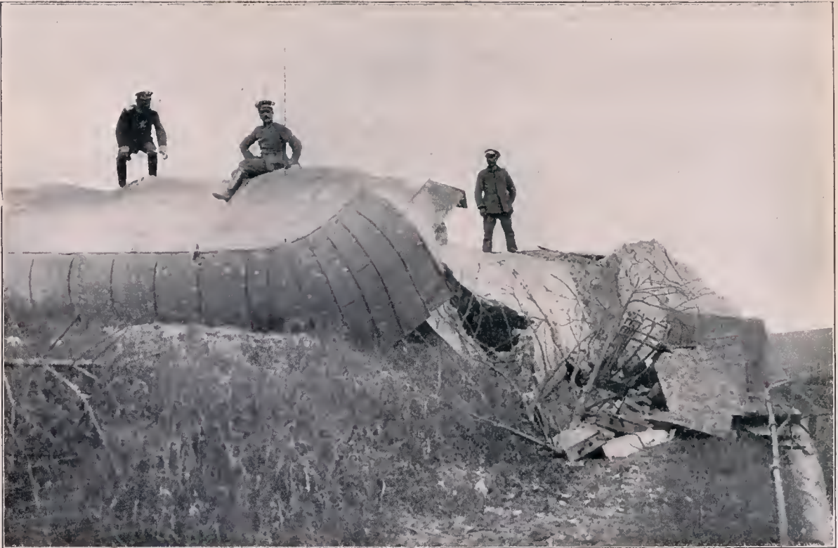
Die Wirkung der 30,5-cm- und der 42-cm-Mörser an einem Panzerturm auf Fort XI vor Przemysl: Die Kuppel eines Geschützturmes, die 30 m weit weggeschleudert wurde.
