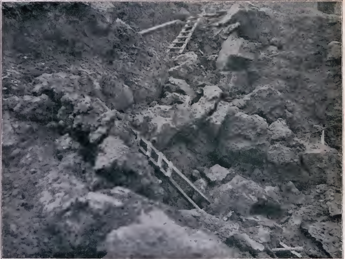
Sprengtrichter eines durch deutsche Pioniere in die Luft gesprengten französischen Schützengrabens. Der gewaltige Erdtrichter, der auch die Überreste der französischen Besatzung birgt, wurde nach der Einnahme durch Anlegen von Leitern und Drahtseilen zugänglich gemacht.
