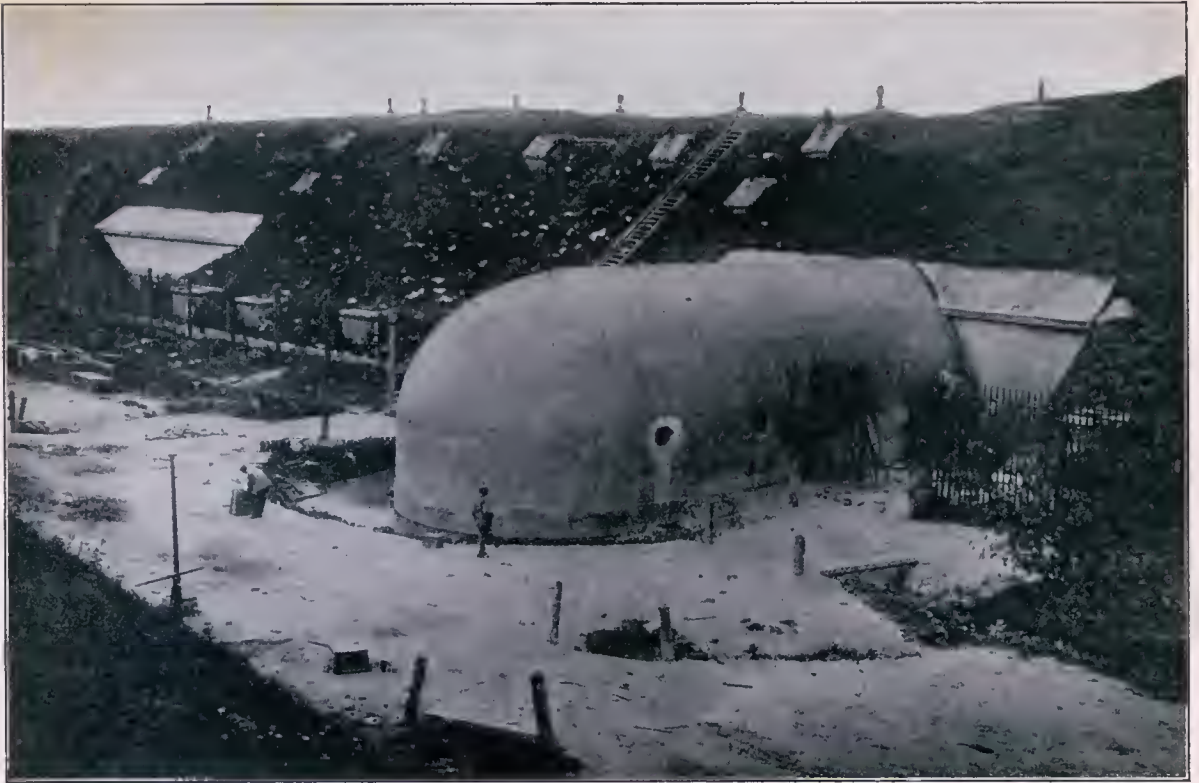
Aus der eroberten Festung Kowno: Betonerte Grabenbestreichung in der Kehle des Forts 8. Geföhrt, Küstewind.
