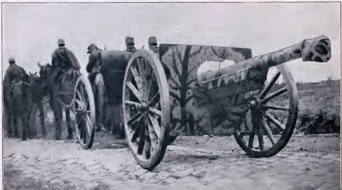
Schutzfarbe im Krieg: Ein französisches Geschütz, das zur Deckung gegen Sicht an Stelle der üblichen Bedeckung durch Zweige dem Kampfplatze durch Übermalung angepasst ist. (Aus „Illustrated War News“.)
