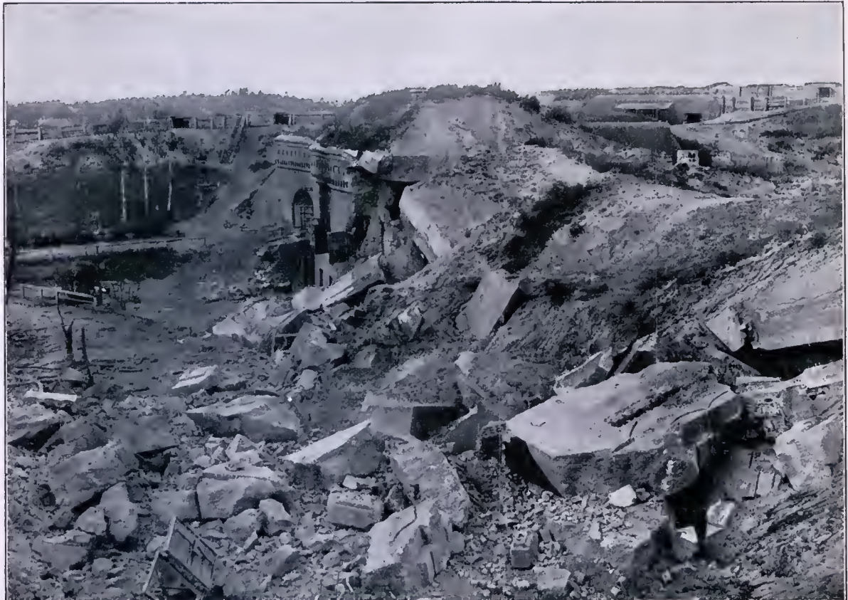
Die Trümmer der Kasematten in der Festung Ossowiec, die von den Russen vor ihrem Abzug gesprengt wurden.
