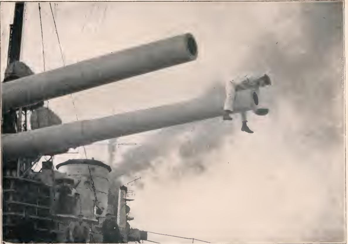
An Bord eines deutschen Schlachtkreuzers: Beim Oelen der Rohrmündstücke.
