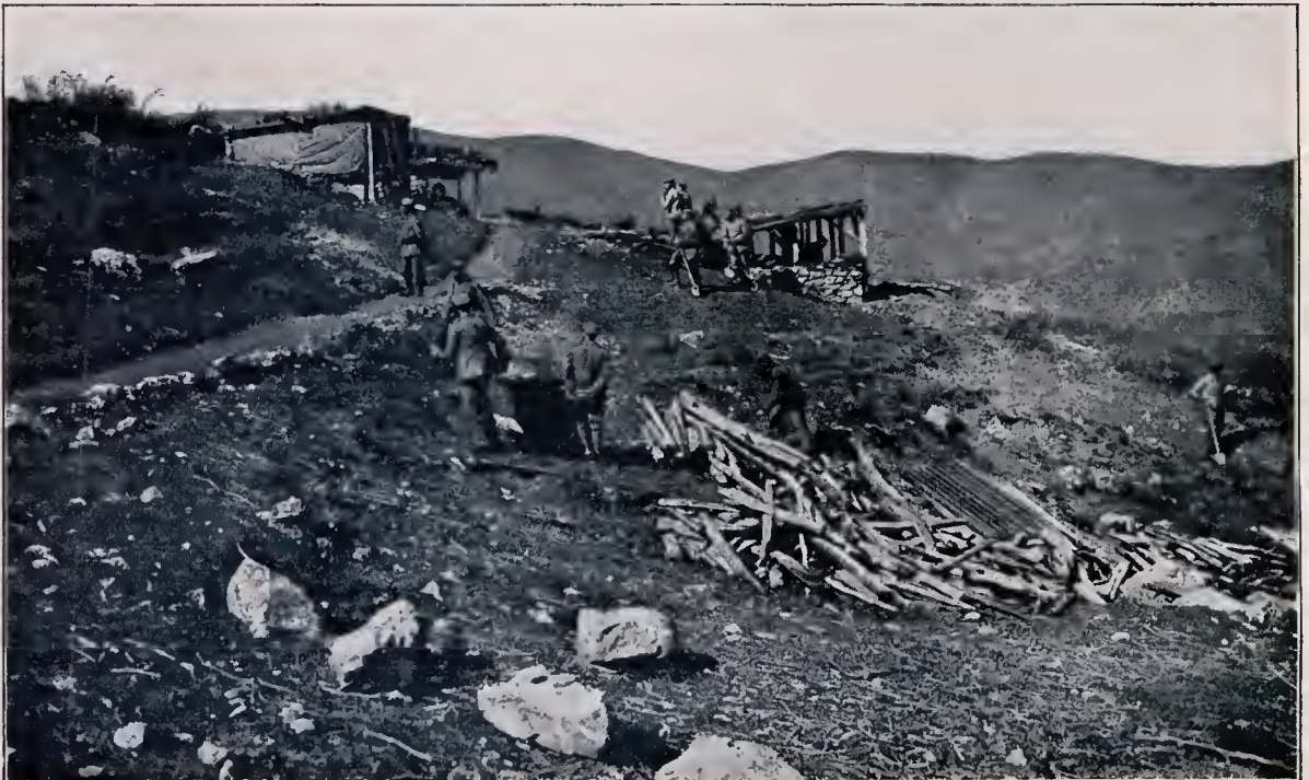
Die Wacht an der griechischen Grenze: Errichtung deutscher Unterstandshütten in den holzarmen Grenzbergen, wo die Beschaffung von Holz große Schwierigkeiten bietet; es muß oft tagewelt herbeigeht werden.
