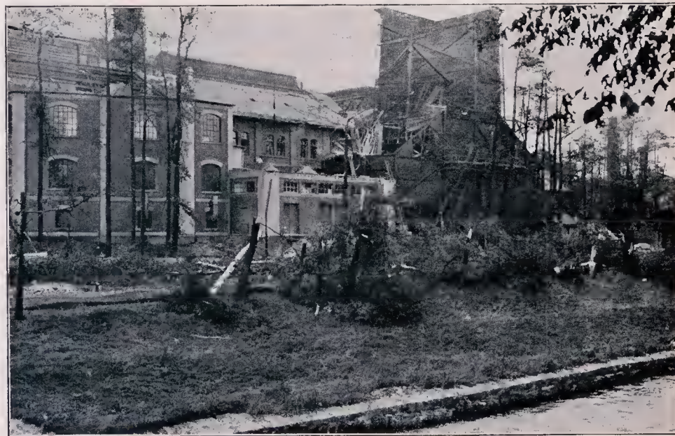
Die Unwetterkatastrophe in Chemnitz. Ein erheblicher Teil des Königreichs Sachsen wurde Ende Mai von einem schweren Unwetter heimgesucht. Besonders großer Schaden wurde in Chemnitz angerichtet, wo durch eine Windhose mehr als hundert Häuser beschädigt, das Dach des Elektrizitätswerks zerstört und die Schloßparkanlagen verwüstet wurden. Unsere Aufnahme zeigt das städtische Elektrizitätswerk, von dessen Dach die Windhose allein 650 Zentner Kupferbelag forttrieb. Durch einen Blitzschlag wurde der Betrieb vier Stunden lang unterbrochen, so daß die ganze Stadt ohne Licht war. Der Gesamtschaden wird in Chemnitz auf mehr als 1 1/2 Million Mark beziffert.
