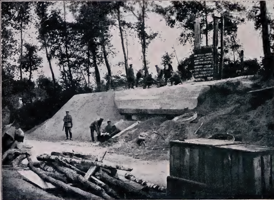
Betonierte Anlagen für einen Transformator auf dem westlichen Kriegsschauplatz. Diese Anlage ist eine von vielen, die von der deutschen Militärverwaltung in Feindesland geschaffen wurden. Transformatoren sind Vorrichtungen zur Überführung von elektrischer Energie von bestimmter Spannung in solche von einer anderen Spannung. Verfertigt: Ostar Zellmann, Gschweige.
