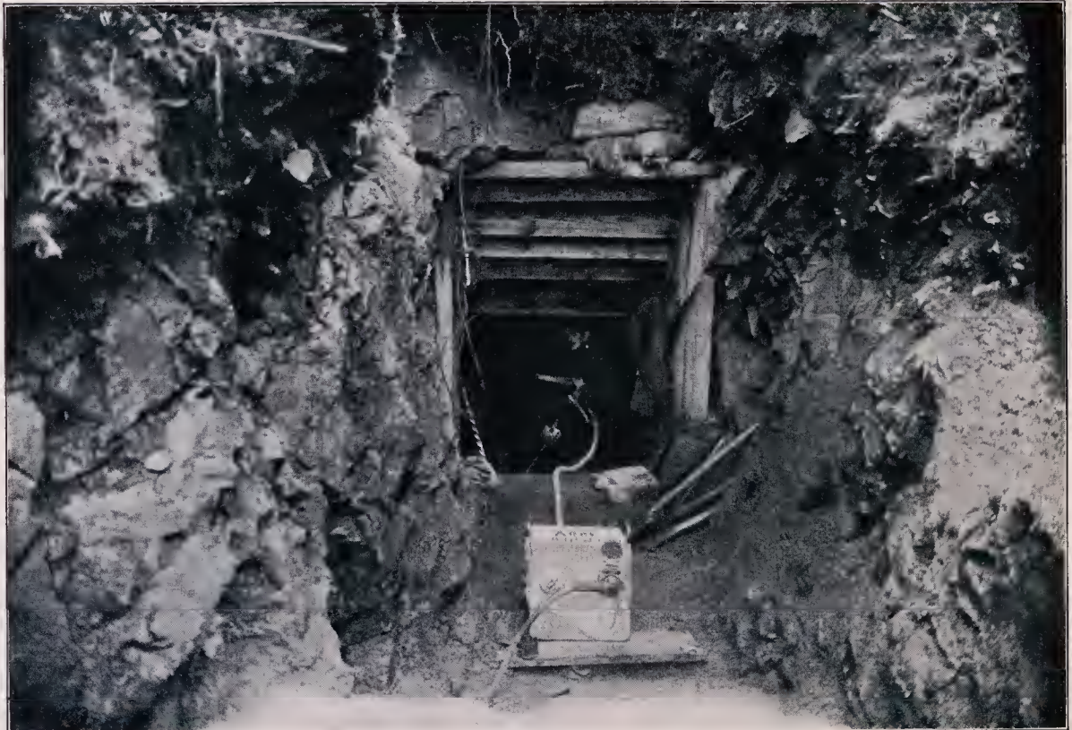
Vom Kriegsschauplatz in den Vogesen: Durchbohren eines Zelfens mittelst eines elektrischen Gesteinbohrers. Phot. Max Wipperting.
