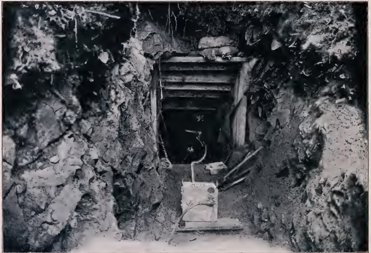
Vom Kriegsschauplatz in den Vogesen: Durchbohren eines Eisens mittels eines elektrischen Gesteinsbohrers. Phot. Max Wippertling.
