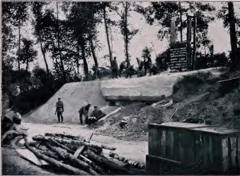
Betonierte Anlagen für einen Transformator auf dem westlichen Kriegsschauplatz. Diese Anlage ist eine von vielen, die von der deutschen Militärverwaltung in Feindesland geschaffen wurden. Transformatoren sind Vorrichtungen zur Überführung von elektrischer Energie von bestimmter Spannung in solche von einer anderen Spannung. Fotohet. Detar Zeugmann, Eschwege.
