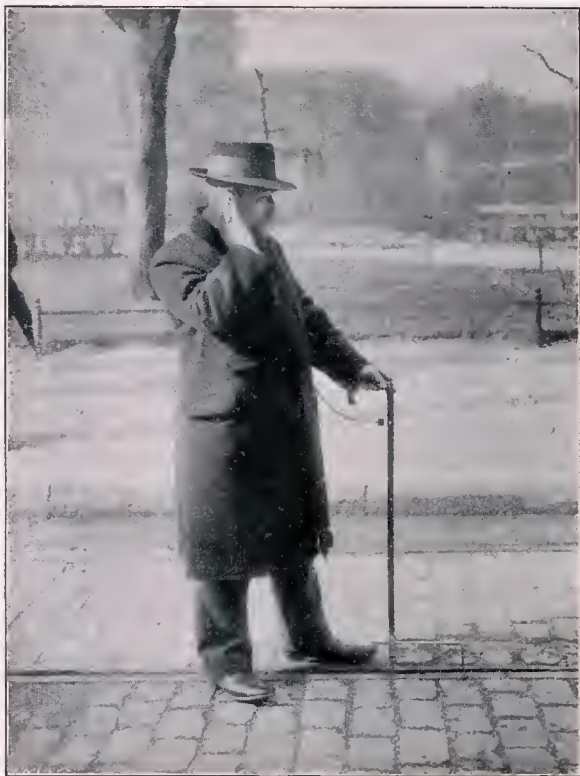
Merkwürdige elektrische Apparate. Links: Der Spazierstock als Schienenprüfer bei elektrischen Bahnen. Der Spazierstock des Ingenieurs ist so eingerichtet, daß dieser durch Abhören mit einem Telephon Störungsstellen beim Begehen der Bahnstrecke auffinden kann. Rechts: Der Fernsprecher in der Westentasche, mit dem man sich an feststehende Fernsprechleitungen anschließen kann
