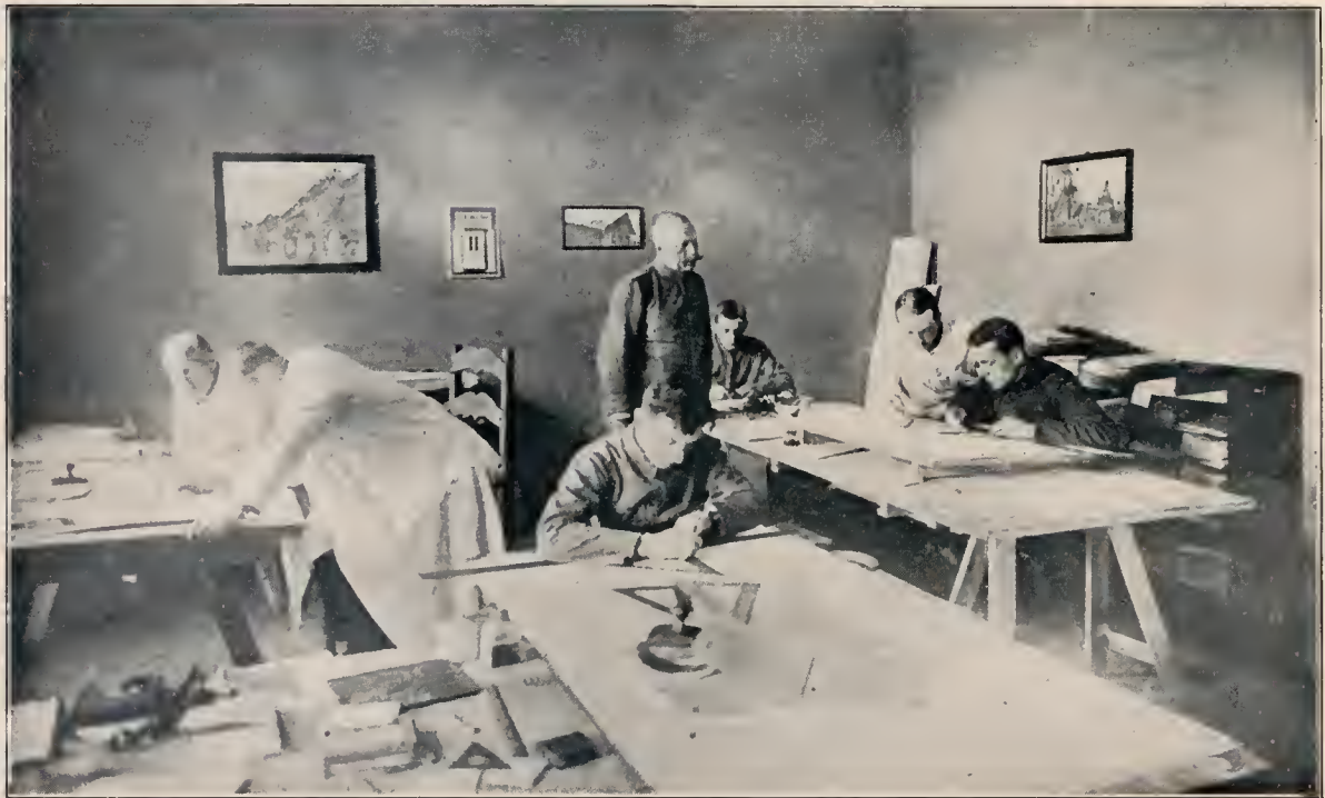
Wie Deutschland seine Kriegsgefangenen behandelt: Ein Baubureau in Ostpreußen mit französischen und englischen Architekten, denen gestattet wurde, an dem Wiederaufbau der von den russischen Horden niedergebrannten und verwüsteten Provinz mitzuwirken. (Spekt. Auslieferung.)
