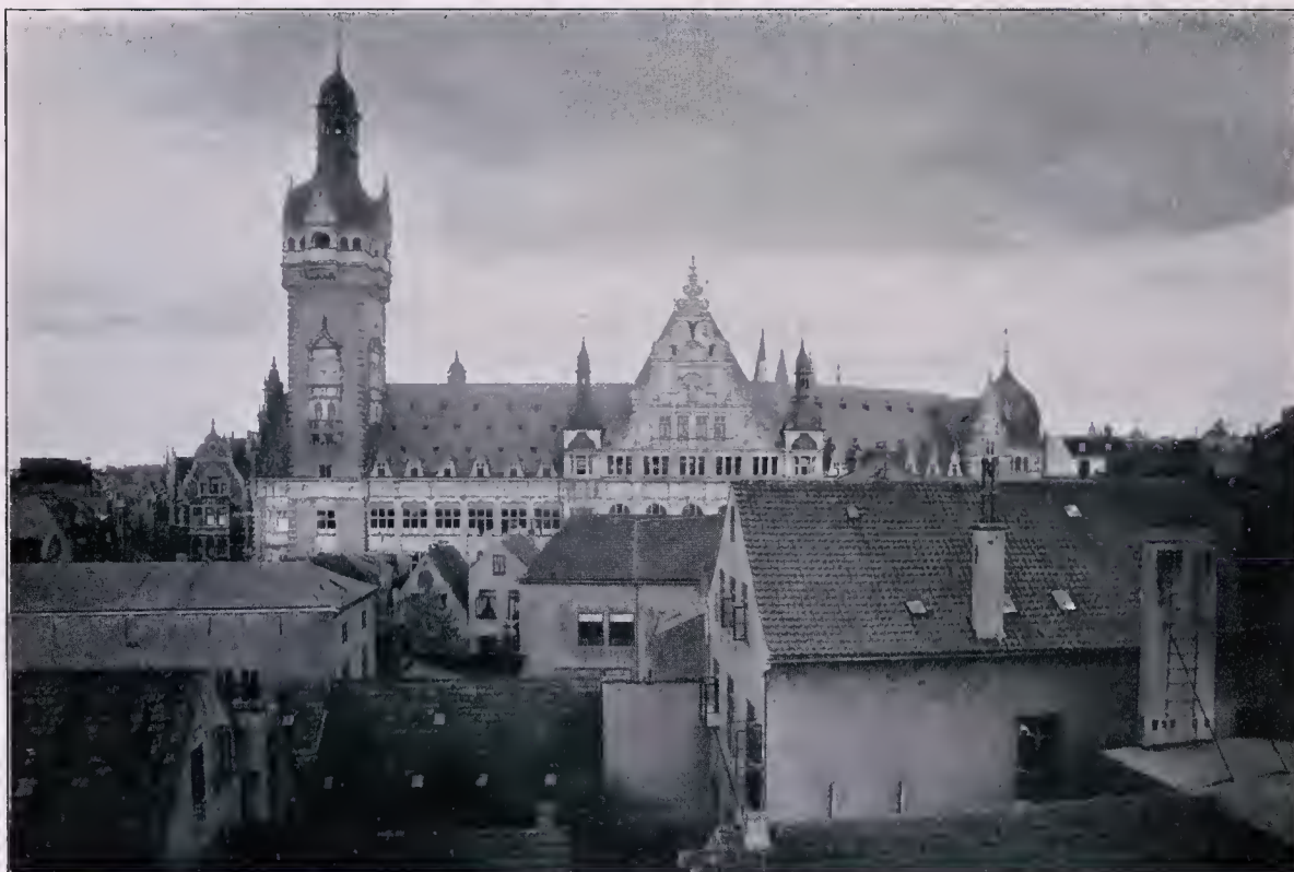
Blick auf das Verwaltungsgebäude des Norddeutschen Lloyd in Bremen.
