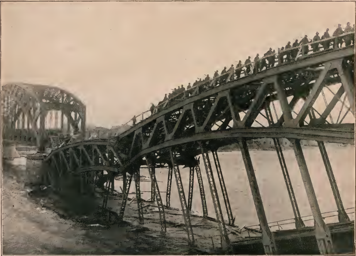
Deutsche Truppen beim Passieren der Eisenbahnbrücke bei Riga, die von den Russen vor ihrem Rückzug gesprengt und von den deutschen Pionieren sofort wieder zu einer Notbrücke ausgebaut wurde. Phot. Bild- und Zeitschrift.
