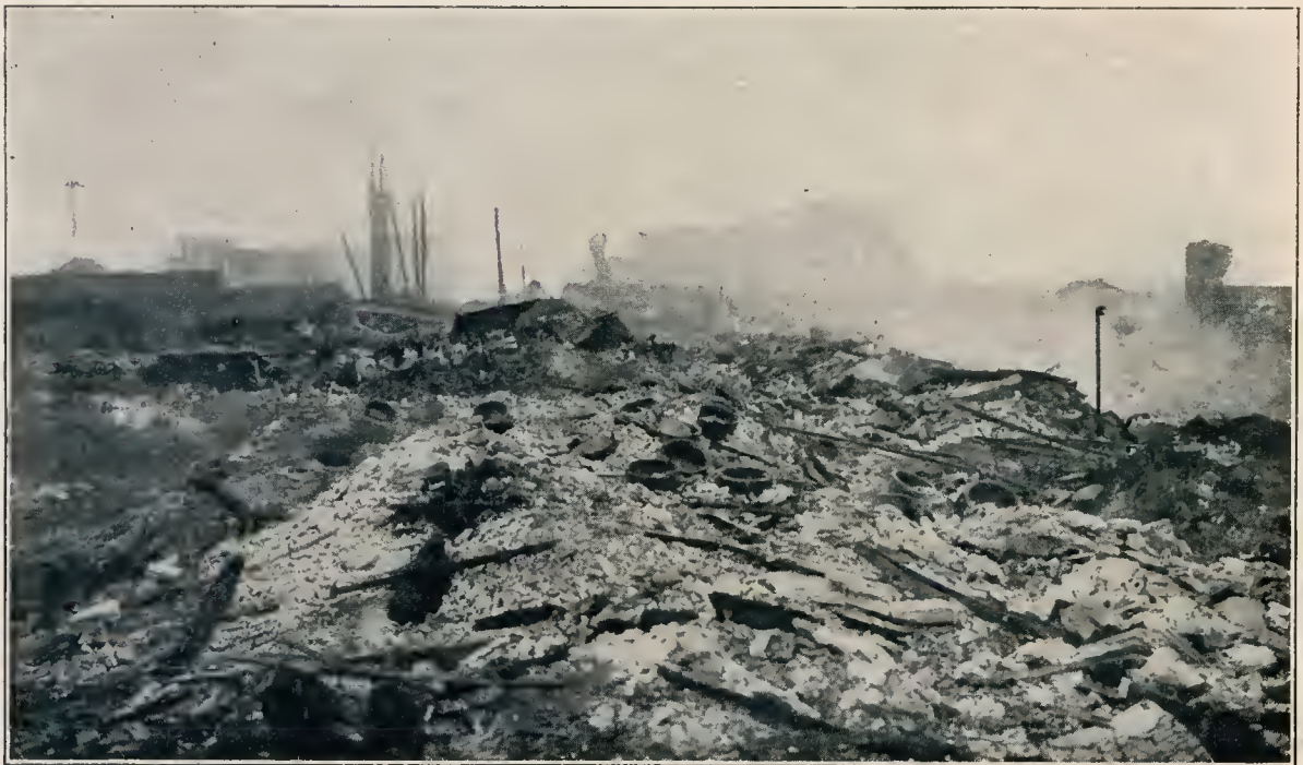
Der Riesenbrand des früheren Kölner Werkbundausstellung, die während des Krieges als Pionierpark diente. Die aufsichtslose Zeit nach dem Durchmarsch der deutschen Truppen und vor dem Einzug der feindlichen Besatzung benutzten dunkle Elemente in Köln zu umfangreichen Plünderungen. Militärische Anlagen, Geschäfte, Fabriken und Lebensmittelmagazine wurden geplündert und zerstört. Auf diesen Beutezilgen wurde auch die Werkbundausstellung ihrer Bestände beraubt und schließlich in Brand gesteckt; neben anderen Baulichkeiten fielen das große Hauptgebäude mit dem Kuppelbau und die niederrheinische Kirche den Flammen zum Opfer. (Hel. Max Zierpeck.)
