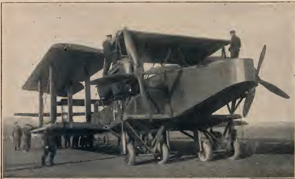
Deutsche Luftbeute: Englisches Großflugzeug (Typ Handley-Page), das unverfehrt in deutsche Hände fiel. Das Flugzeug ist 30 m breit, 20 m lang und 6 1/2 m hoch, hat zwei Motoren zu je 260 P. S., die zwei vierflüglige Propeller treiben, Bewaffnung: 3 Maschinengewehre, Besatzung: 5 Mann.
