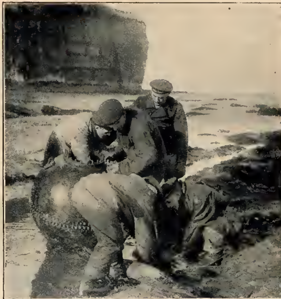
Eine angeschwemmte englische Mine auf Helgoland. Die Schießbaumwolle wird aus der Mine, die zwei Zentner Sprengstoff enthält, entfernt. Phot. Fild- und Kilmann.
