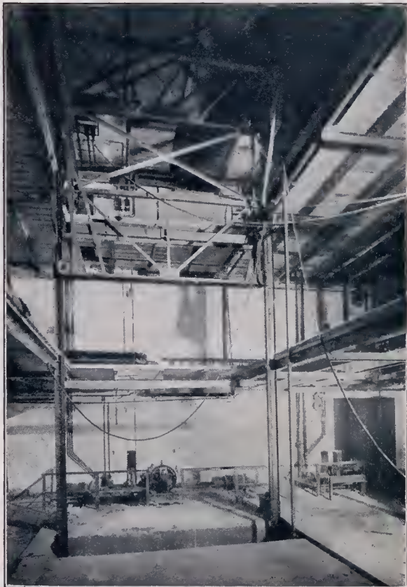
Elektrische Verfeulungsmaschinerie. Drei Gefchoffe unter dem Bühnenpodium. Die Plattform der Verfeulung befindet sich in der Höhe des Podiums.
