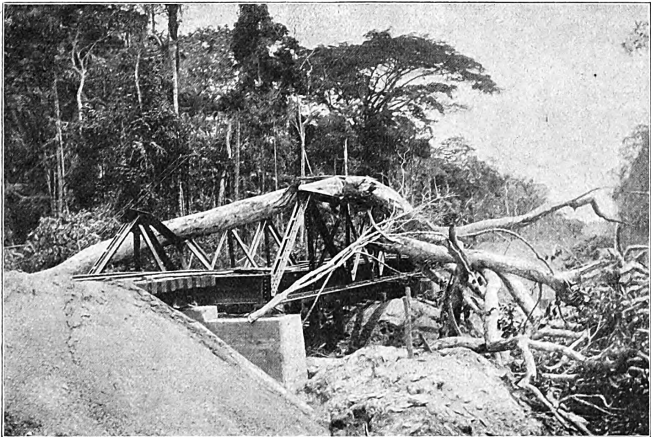
Im tropischen Urwald. Ein gefallener Baumriese hat die Brückengeländer zerstört.
