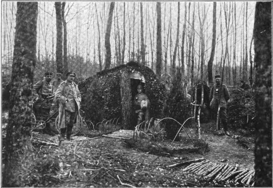
Erdbwohnungen in den Argonnen. Phot. A. Remgenberf.
