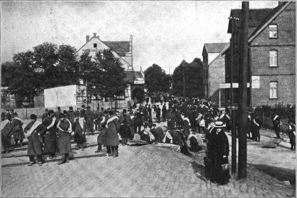
französische Kriegsgefangene bei der Arbeit. Sie befördern das Material zu den Barackenbauten im Sennelager, wo sich bereits 22.000 gefangene Franzosen und Engländer befinden und das infolge großen Andrangs andauernd erweitert werden muß. Die Franzosen, von denen jeder seine Schlafbede bei sich führt, werden zumeist als gutmütig geschildert, während die englischen Gefangenen ein herausforderndes Benehmen zeigen. Holtpet. Ubrich, Kallst.
