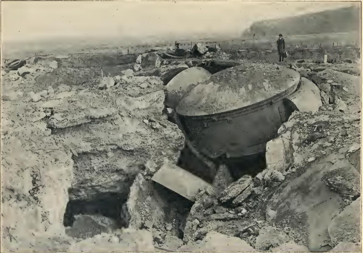
Vom belgischen Kriegsschauplatz: Die mehrere Meter starke Betonbedeckung eines belgischen Forts, die ebenso wie die beweglichen Panzertürme durch einen Schuß der deutschen 42-cm-Gaubizen zerstört wurde. Das Geschöß drang bis zur Munitionskammer durch, so daß das ganze Fort in die Luft flog.
